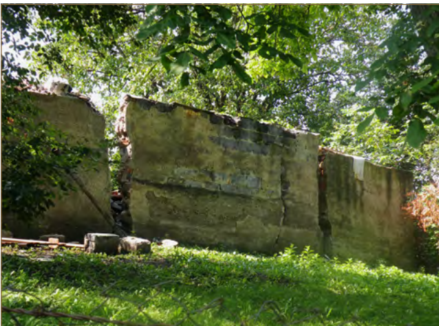
Obr. 8.50: Trhliny v múroch (foto: V. Jánová)
