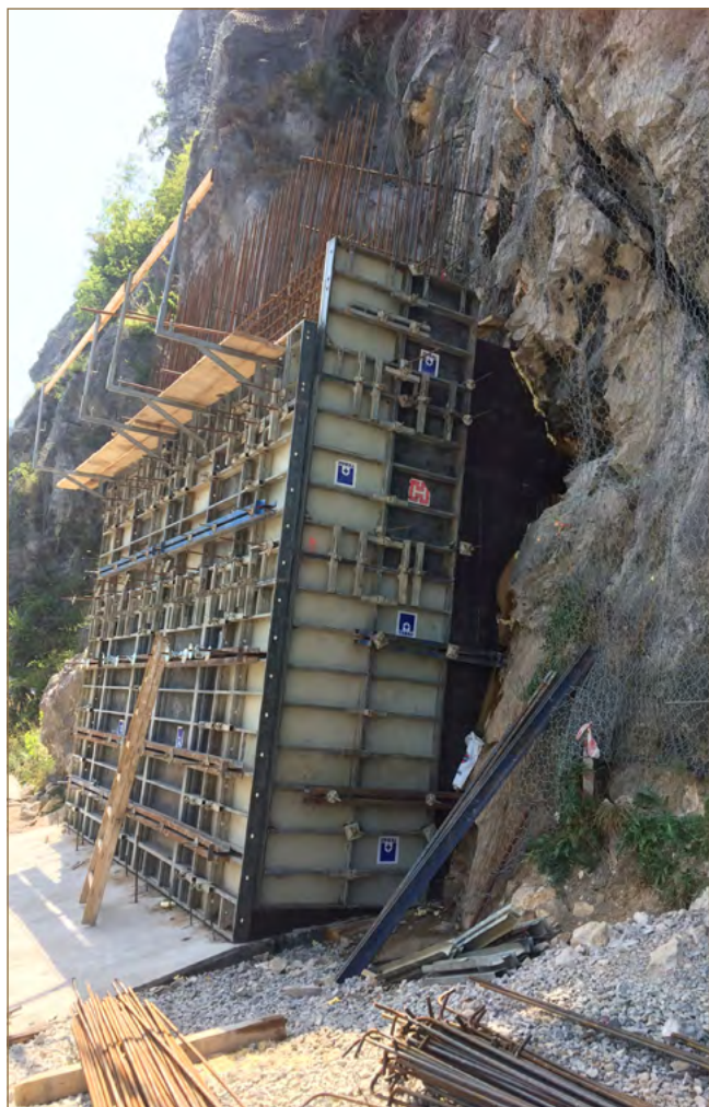
Obr. 11.67: Výstavba železobetónového oporného múra na stabilizáciu previsov nad štátnou cestou 1. triedy pod hradom Strečno (foto: V. Jánová, K. Házyová)
