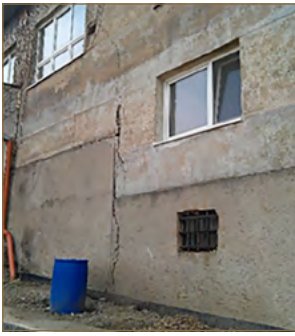
Obr. 8.57: Poškodený obecný úrad a stav po vybudovaní pilótovej podzemnej steny (foto: V. Jánová)
