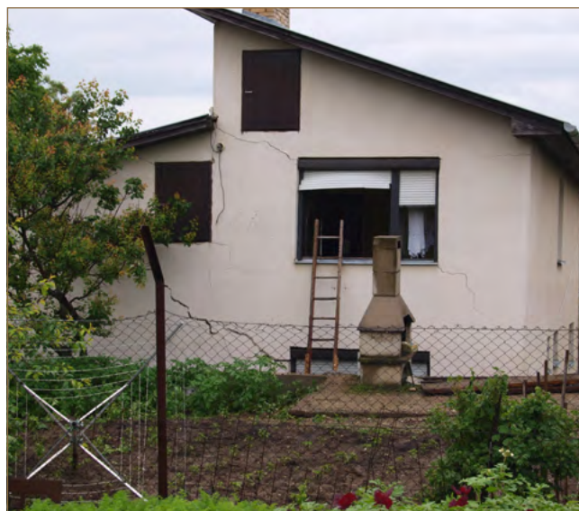
Obr. 5.19: Zosuvom porušený dom v Nižnej Myšli (foto: Ľ. Petro)
