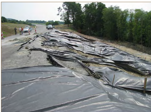
Obr. 11.14: Prekrytie trhlín v odľučnej oblasti zosuvu na násype trasy R4 pri Svidníku (foto: M. Kopecký)
