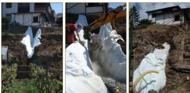
Obr. 8.19: Budovanie drenážno-stabilizačného rebra na zosuve v Krupine (foto: P. Liščák, T. Bvoc)
