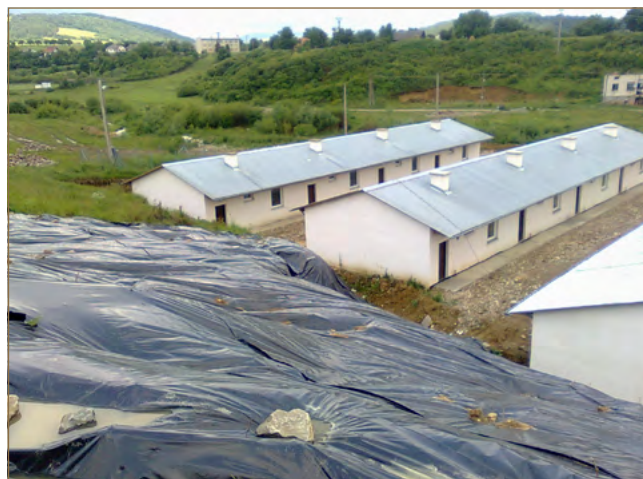
Obr. 11.15: Prekrytie aktívneho zosuvu v obci Chmiňany (foto: V. Jánová)
