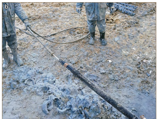
Obr. 11.44: Osadenie lanovej horninovej kotvy (a) a zálievka vnútra kotvy (b) (Gomolčák a kol., 2015)
