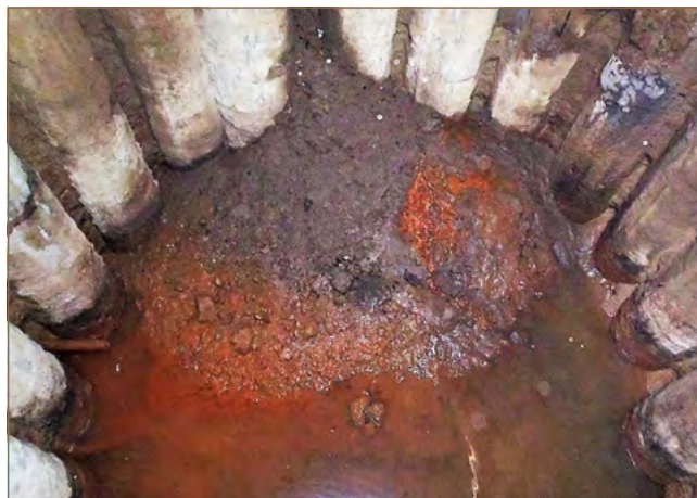
Obr. 11.21: Šachta s horizontálnymi vrtmi v Handlovej – Morovnianske sídlisko (foto: Z. Jasovský)
