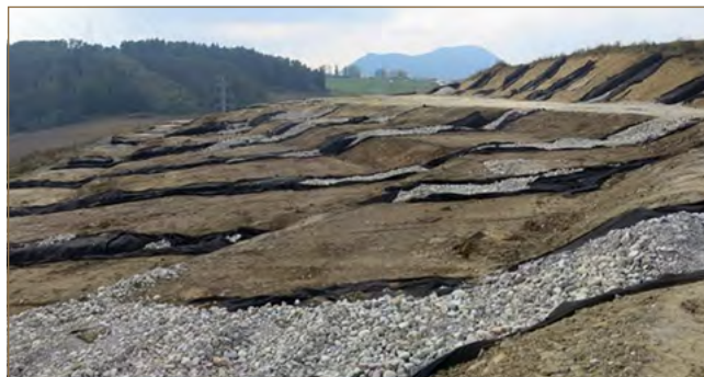
Obr. 11.22: Odvodňovacie rebrá cez zosuvné územie – diaľnica D1 Hubová – Ivachnová (foto: M. Kopecký)
