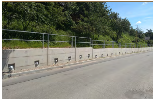
Obr. 11.34: Kotvenie porušeného svahu v Košiciach, Ul. 1. mája (foto: K. Házyová) a kotvený oporný múr v obci Červený Kameň (foto: V. Jánová)
