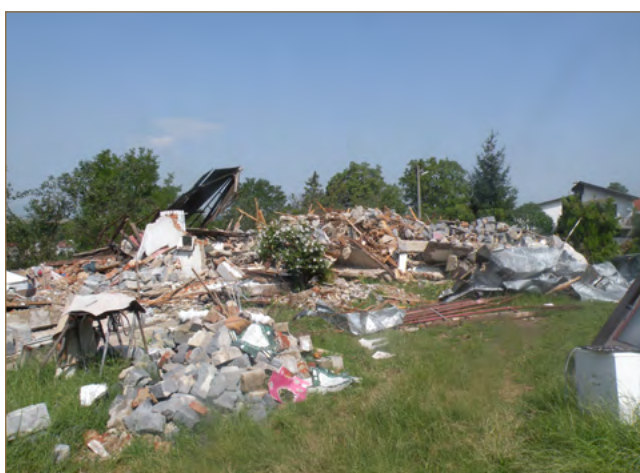
Obr. 8.6: Rodinné domy s porušenou statikou museli byť zbúrané (foto: K. Házyová)
