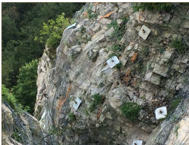
Obr. 11.51: Ukážka ochranných sietí na skalnom brale v Strečne (foto: V. Jánová)
