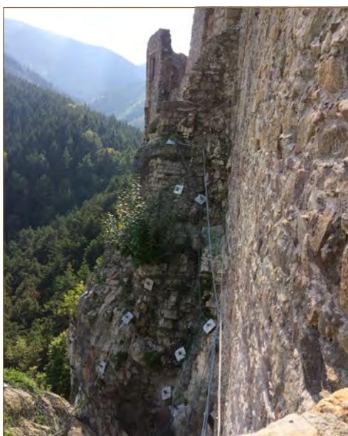
Obr. 11.51: Ukážka ochranných sietí na skalnom brale v Strečne (foto: V. Jánová)
