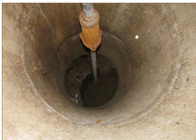
Obr. 9.24: Zachytená šmyková plocha (posun skruže) v domovej studni (foto: M. Kopecký)
