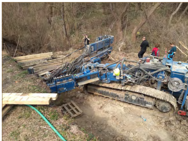
Obr. 11.18: Vrtanie subhorizontálneho odvodňovacieho vrtovej na zosuve v Kapušanoch a vejára odvodňovacích vrtovej na zosuve vo Varhaňovciach (foto: K. Házyová)
