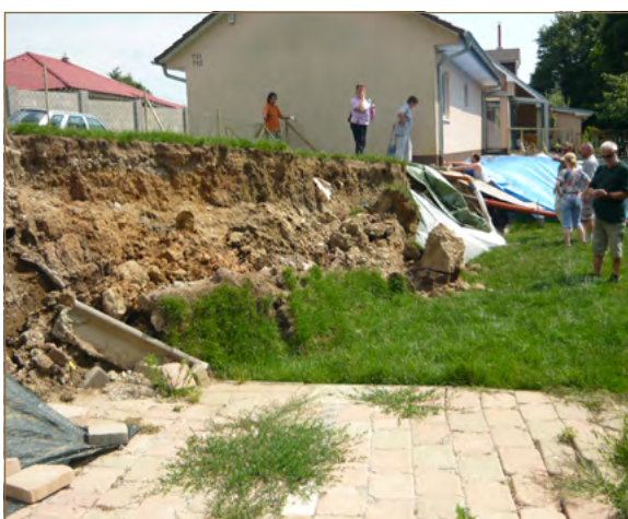
Obr. 5.20: Odlučná hrana zosuvu vo Vinohradoch nad Váhom (vľavo) a budovanie mikropilótovej steny na záchranu rodinného domu (vpravo) (foto: V. Jánová)
