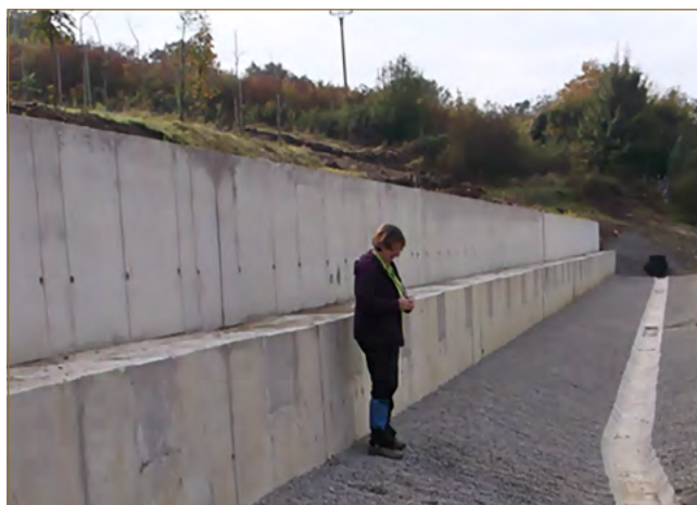
Obr. 11.33: Dokončený kotvený oporný múr nad základnou školou v obci Nižná Myšľa (foto: V. Jánová)
