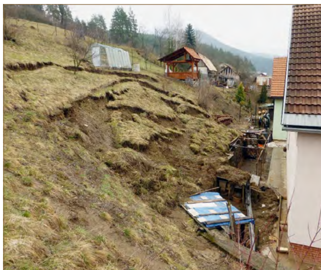
Obr. 3.11: Dôsledok podrezania svahu v obci Brusno (foto: R. Jelínek)
