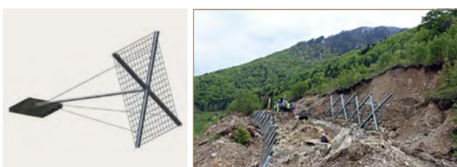
Obr. 11.35: Konštrukcia ErdoX Terra (vľavo) a spôsob jej zabudovania (vpravo) (Prelovský, Sňahničan, 2019)
