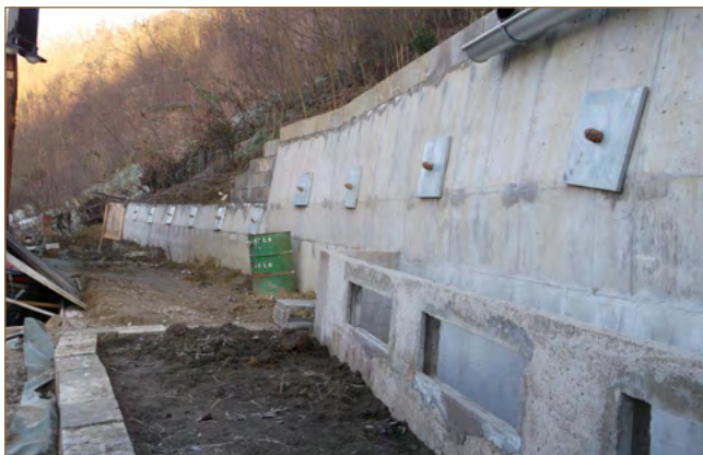
Obr. 11.34: Kotvenie porušeného svahu v Košiciach, Ul. 1. mája (foto: K. Házyová) a kotvený oporný múr v obci Červený Kameň (foto: V. Jánová)
