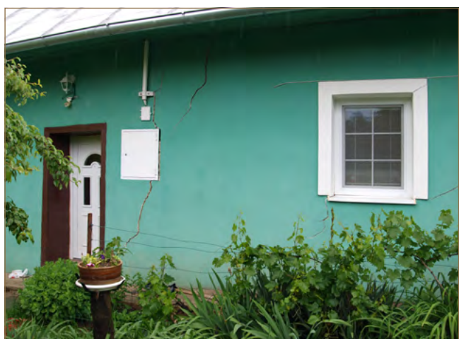
Obr. 8.46: Zosuvom silno poškodené rodinné domy (foto: Ľ. Petro)
