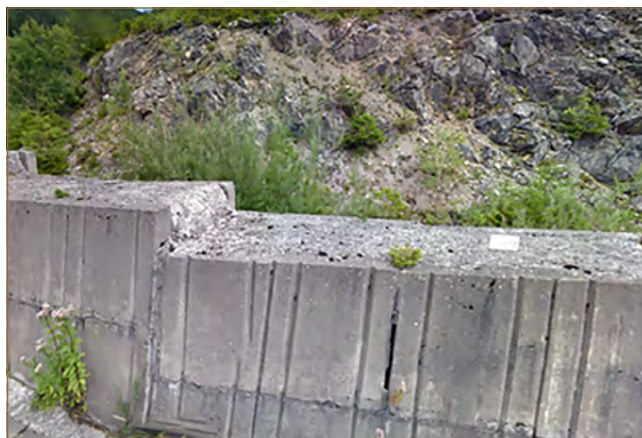
Obr. 11.72: Príklady záchytných múrov na odkryvoch severne od obce Demjata a na ceste medzi Liptovskými Matiašovcami a Hutami (zdroj: www.google.sk/maps )
