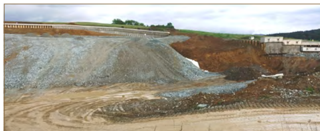
Obr. 11.6: Zosuv svahu (hrúbka 5 m) odrezu na križovatke Lietavská Lúčka (D1 – Višňové) a jeho výmena za lomové kamenivo (foto: M. Kopecký)
