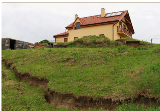
Obr. 8.45: Odlučné hrany v rôznych častiach zosuvu v Nižnej Myšli (foto: Ľ. Petro)
