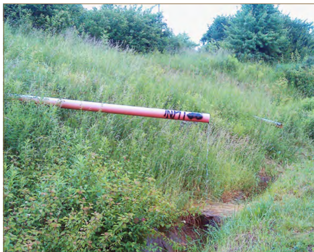
Obr. 8.56: Budovanie podpovrchového odvodnenia a vybudované subhorizontálne odvodňovacie vrty (foto: V. Jánová, L. Petro)
