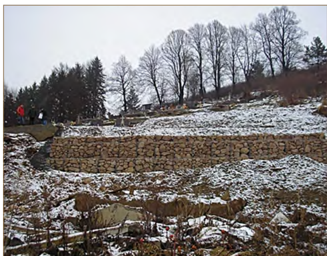
Obr. 8.37: Pohľad na sanovaný svah na cintoríne v Chmelnici (foto: J. Šimeková)
