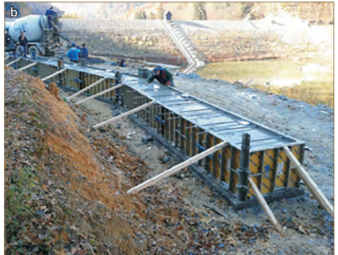
Obr. 11.42: Zriadenie armatúry kotevného mostíka a osadenie prechodiek kotiev (a) a betonáž kotevného mostíka (b) (Gomolčák a kol., 2015)
