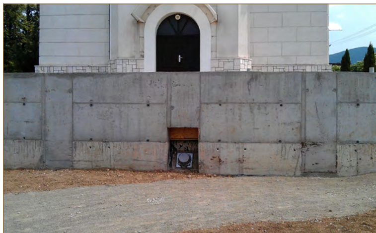
Obr. 8.53: Porušené územie pod kostolom pred sanáciou a po sanácii (foto: L. Petro, V. Jánová)
