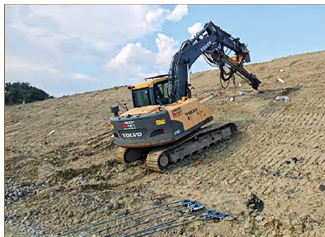
Obr. 11.38: Zarážanie mechanickej kotiev hydraulickým kladivom na pásovom podvozku na stavbe D1 Budimír – Bidovce (Prelovský, Sňahničan, 2018)
