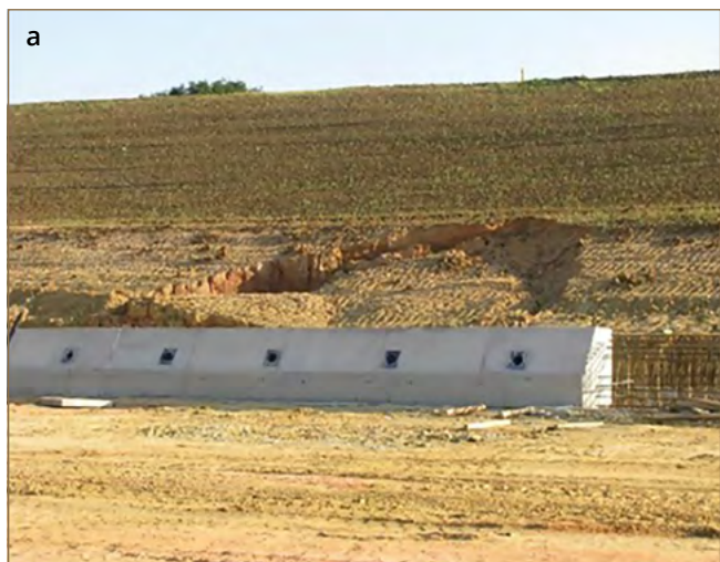
Obr. 11.39: Sanácia zárezu v zosuve na trase R4 Košice – Milhošť pilótvou stenou: a) aktivizácia zosuvu pred dokončením pilótovej steny, b) dokončená pilótvá stena (foto: M. Kopecký)
