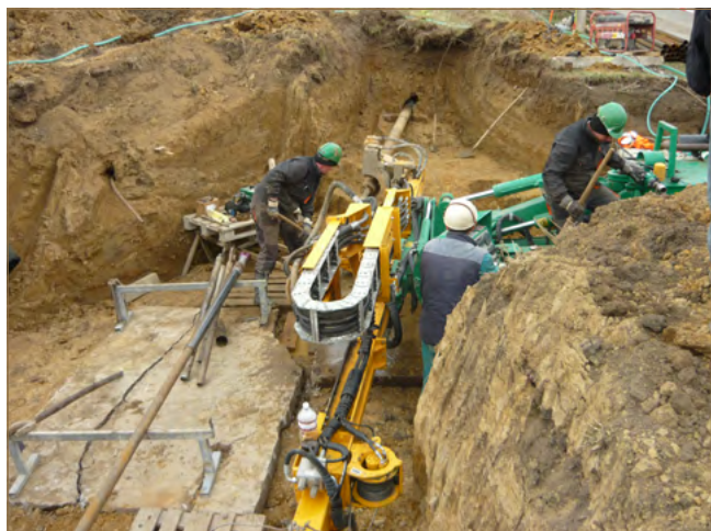
Obr. 11.18: Vrtanie subhorizontálneho odvodňovacieho vrtovej na zosuve v Kapušanoch a vejára odvodňovacích vrtovej na zosuve vo Varhaňovciach (foto: K. Házyová)
