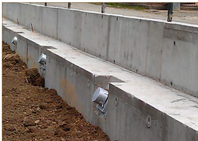
Obr. 11.30: Kotvený oporný múr na zosuve Nižná Myšľa (foto: V. Jánová)
