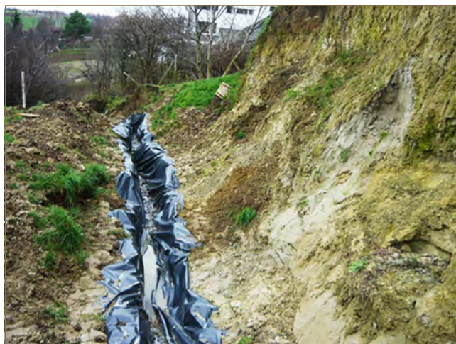
Obr. 11.13: Prekrytie otvorených trhlín v zosuve v obci Šenkvice (foto: K. Házyová)
