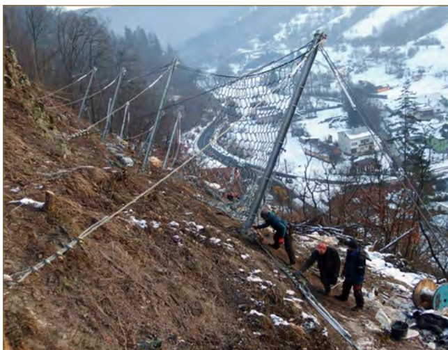
Obr. 11.63: Dynamická bariéra v obci Kozelník bola kvôli nedostupnosti terénu inštalovaná za pomoci vrtuľníka (foto: A. Ilkanič)
