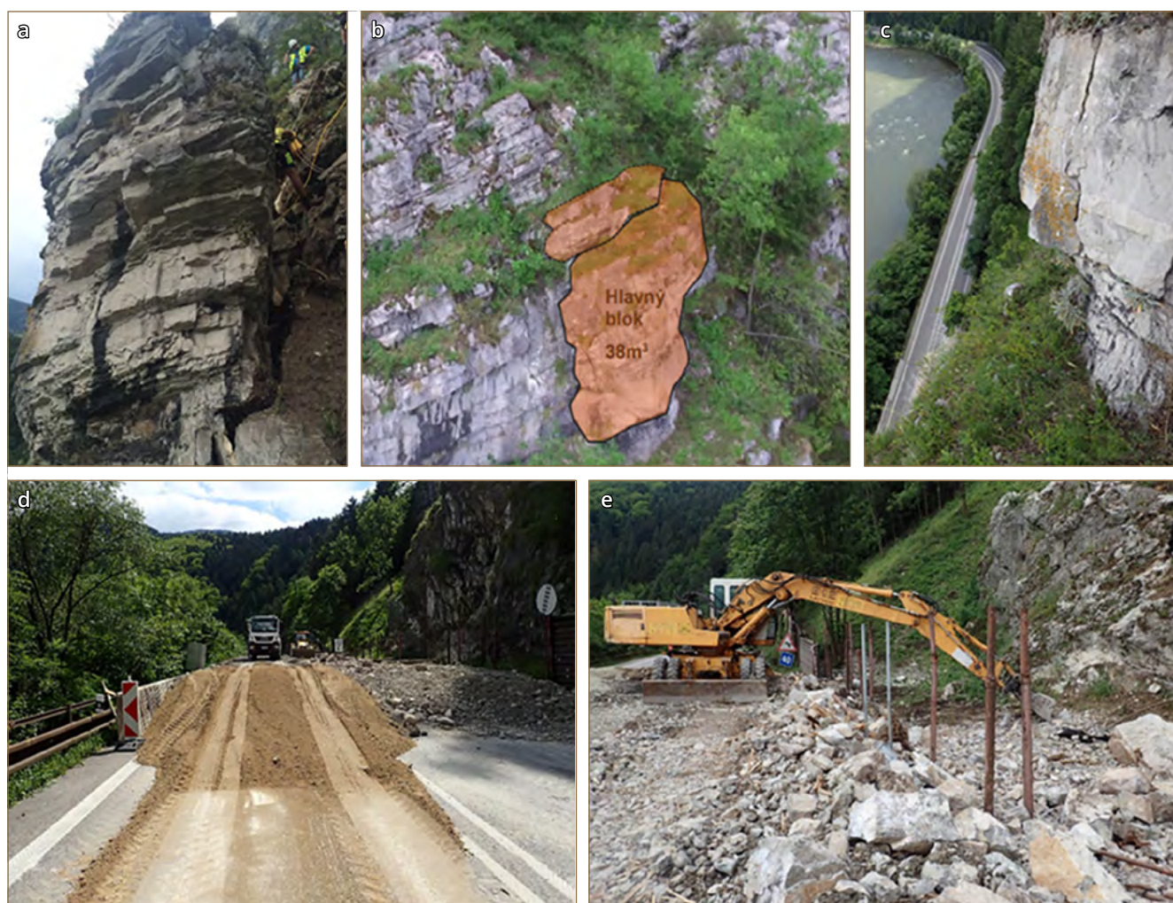
Obr. 11.55: Odstraňovanie nestabilných blokov hornín zo skalného brala v Strečne; a, b, c – nestabilný skalný blok pred jeho odstránením, d – „vankúš“ z lomového kameňa na ochranu vozovky pred poškodením, e – odstraňovanie úlomkov deštruovaného skalného bloku po jeho páde (Bohátka, 2017)
