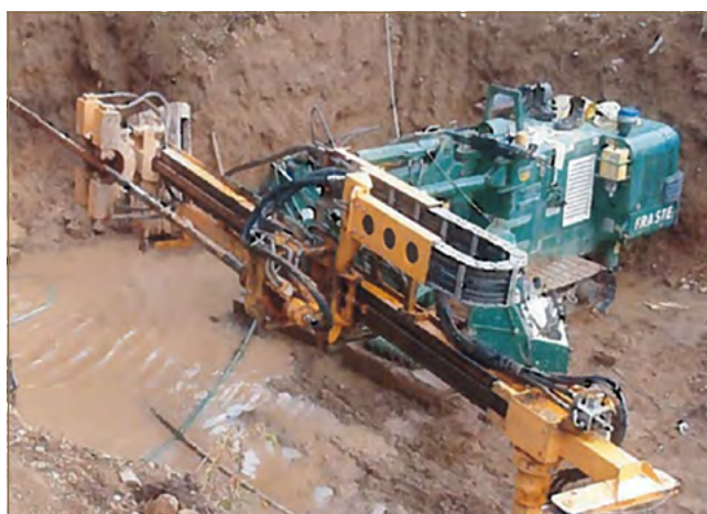
Obr. 8.26: Vrtanie subhorizontálnych odvodňovacích vrtov v Kapušanoch (foto: F. Lafférs)
