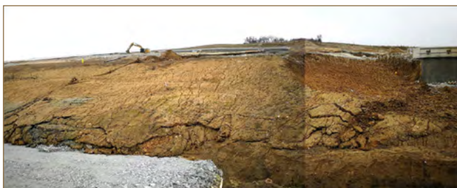
Obr. 11.6: Zosuv svahu (hrúbka 5 m) odrezu na križovatke Lietavská Lúčka (D1 – Višňové) a jeho výmena za lomové kamenivo (foto: M. Kopecký)
