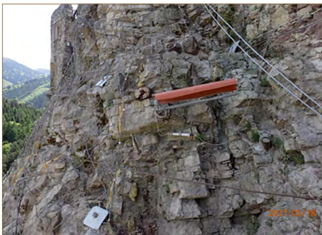
Obr. 11.52: Detail skalného bloku pod hradom Strečno zaisteného HEA panelmi po vykonanej injektáži živcou Geoflex (Fekeč a kol., 2017)
