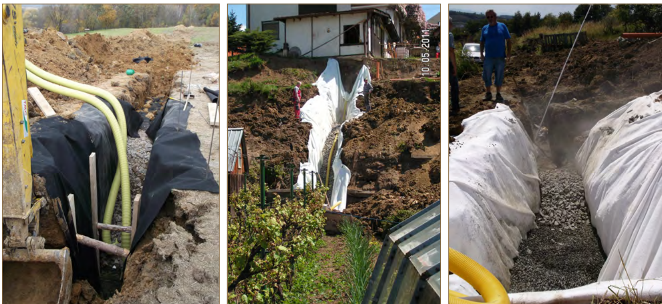
Obr. 11.24: Ukážka budovania odvodňovacích rebier na zosuvoch Prievidza-Hradec, Krupina a Kapušany (foto: K. Házyová)
