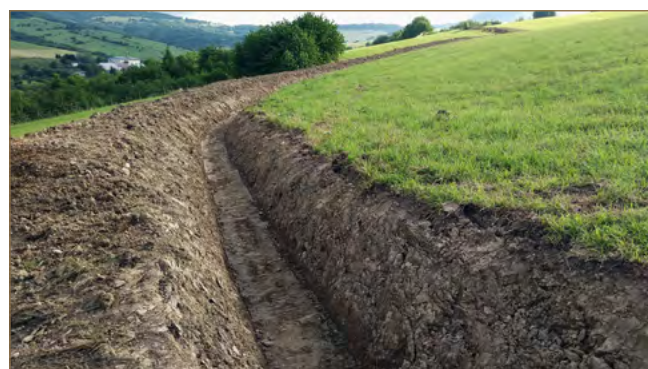
Obr. 11.8: Príklady obvodových nespevnených rigolov a rigolu spevneného geotextíliou (foto: V. Jánová)
