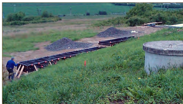
Obr. 11.25: Budovanie drenážnej štrkovej steny na zosuve v Nižnej Myšli (foto: K. Házyová)
