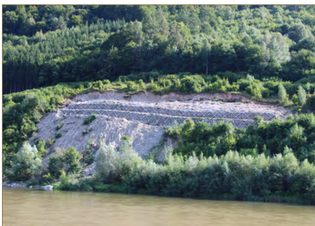
Obr. 11.36: Konštrukcia ErdoX Terra po zabudovaní v Kralovanoch (Prelovský, Sňahničan, 2019)
