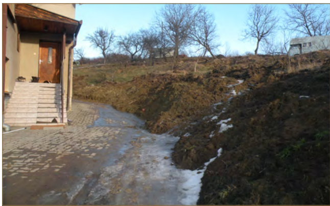
Obr. 8.13: Čelo aktívneho zosuvu v Petrovanoch zasahujúce k rodinnému domu (foto: V. Jánová)
