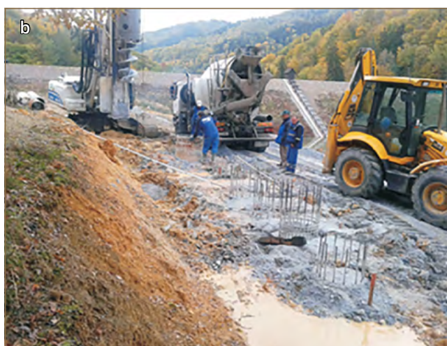
Obr. 11.41: Pohľad dovnútra pilóty pred betonážou (a) a na hlavy železobetónových pilót (b) (Gomolčák a kol., 2015)
