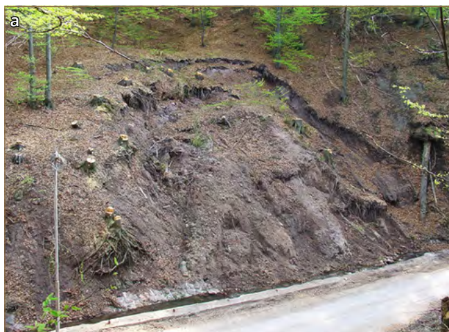
Obr. 3.21: Zosuvy vyvolané topením snehu na jar roku 2006; a – zosuv, ktorý prekryl prístupovú cestu do obce Lukavica (foto: M. Kopecký), b – zosuv, ktorý prerušil železničnú dopravu na trase Myjava Poriadie (www.vlaky.net)
