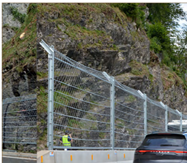
Obr. 11.61: Príklad mobilných plotových bariér Geobrugg (zdroj: www.geobrugg.com )
