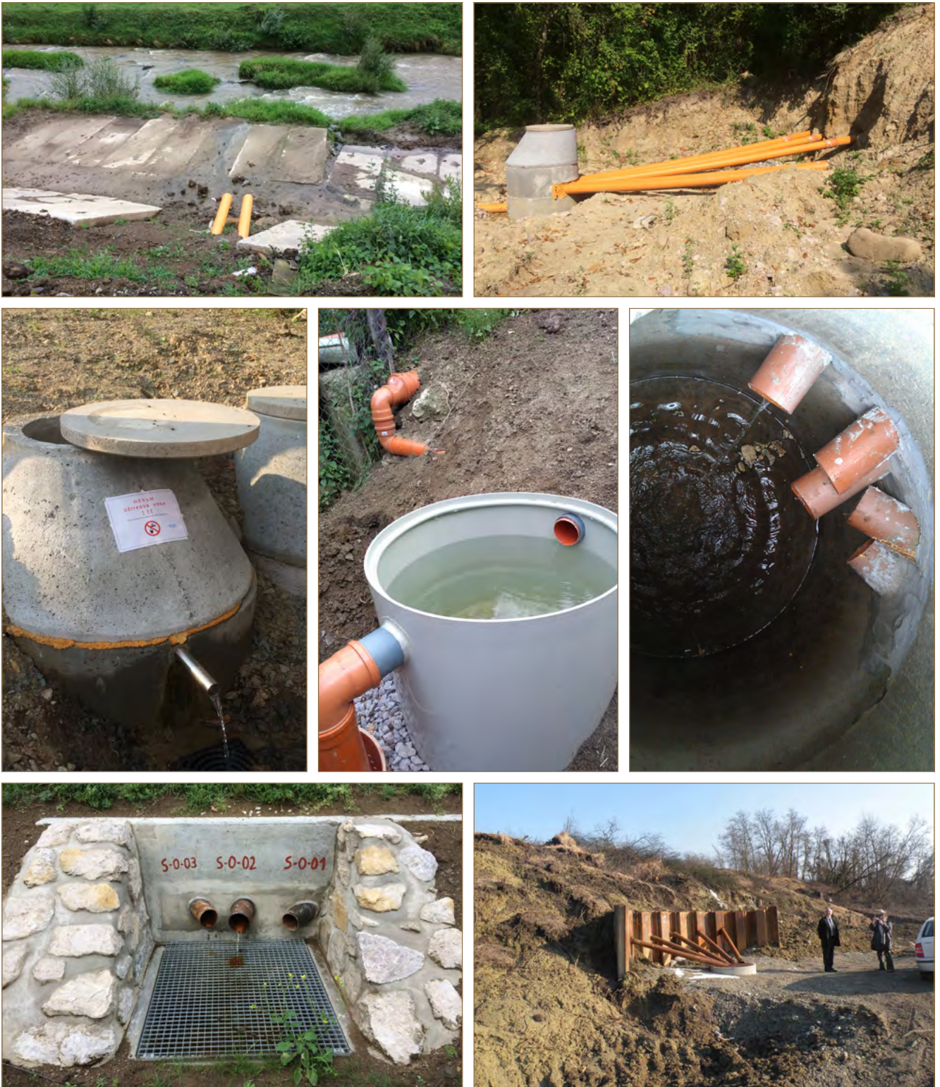
Obr. 11.19: Príklady ukončenia subhorizontálnych odvodňovacích vrtov (foto: V. Jánová)
