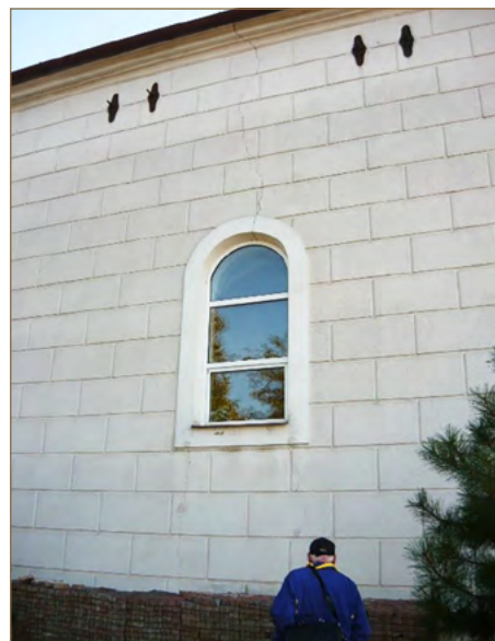
Obr. 5.17: Odlučná hrana zosuvu pod kostolom v Nižnej Myšli a poškodený múr kostola (foto: Ľ. Petro)
