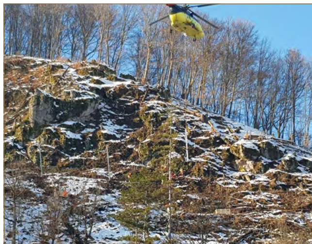
Obr. 11.63: Dynamická bariéra v obci Kozelník bola kvôli nedostupnosti terénu inštalovaná za pomoci vrtuľníka (foto: A. Ilkanič)
