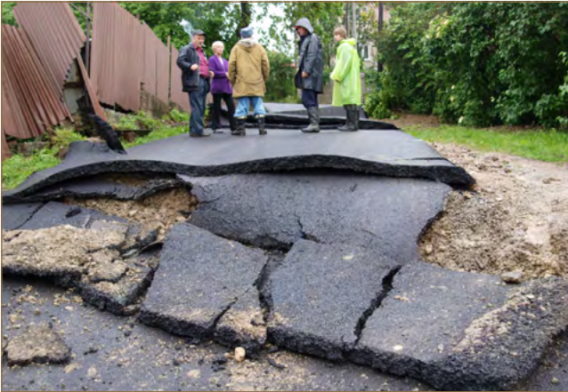
Obr. 8.49: Zosuvom poškodené miestne komunikácie (foto: Ľ. Petro)
