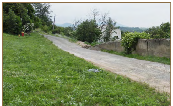
Obr. 8.59: Zosuvom zdeformovaná komunikácia a jej stav po sanácii (foto: V. Jánová)
