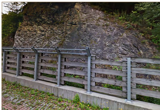
Obr. 11.60: Príklad použitia drevených bariér pod skalným bralom v Strečne a na ceste na Donovaly (zdroj: www.google.sk/maps )
