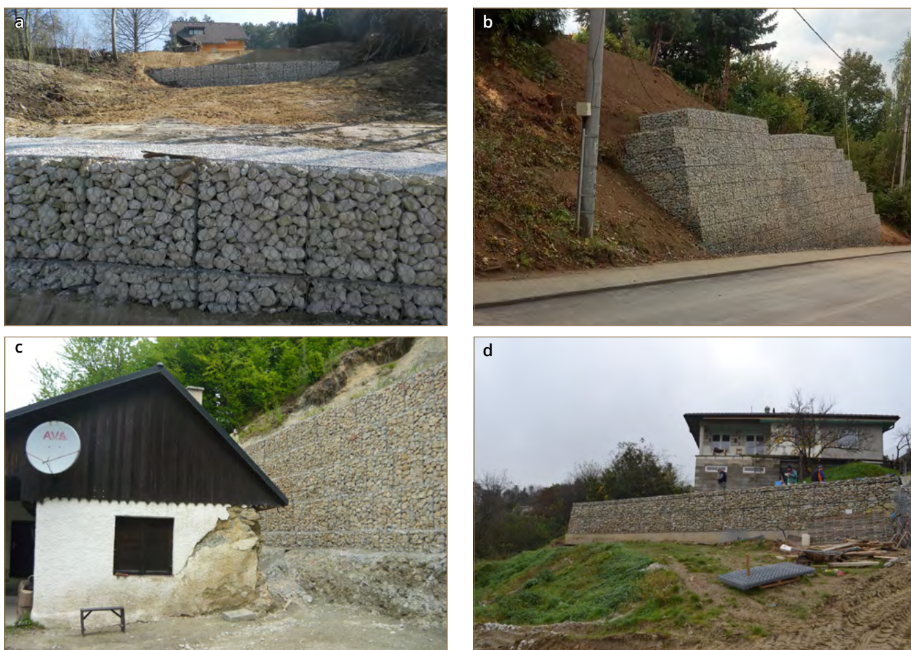
Obr. 11.28: Príklady použitia oporných múrov z gabiónov pri sanácii porušených svahov v obciach: a – Banka (foto: K. Házyová), b – Likavka (foto: P. Tupý), c – Kojšov (foto: K. Házyová), d – Šenkvice (foto: M. Bednarik)
