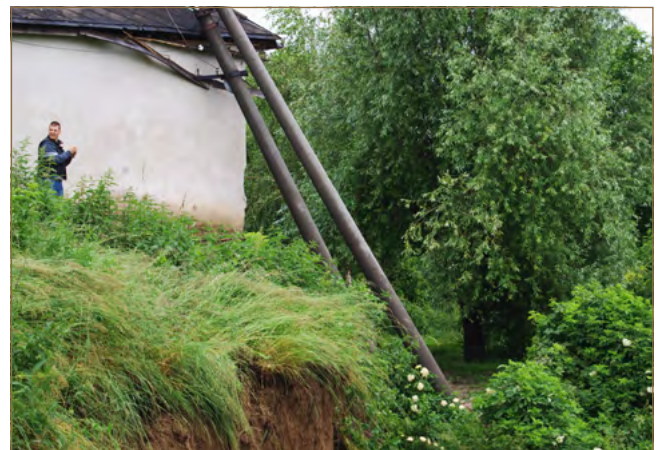
Obr. 8.51: Rozbahnené zosuvné masy v dôsledku poškodených potrubí a vyvrátené elektrické stĺpy sú dôkazom poškodenia inžinierskych sietí (foto: Ľ. Petro)
