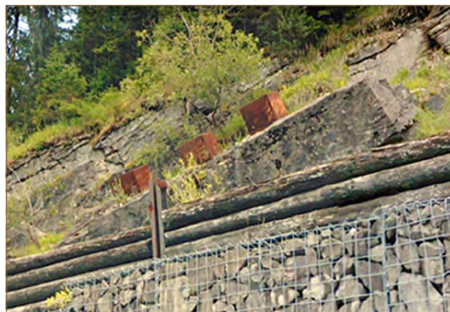
Obr. 11.57: Kotvami stabilizovaný previs na skalnom brale v Strečne (foto: V. Jánová) a kotvami stabilizované lavice pieskovca v lokalite Huty (zdroj: www.google.sk/maps )
