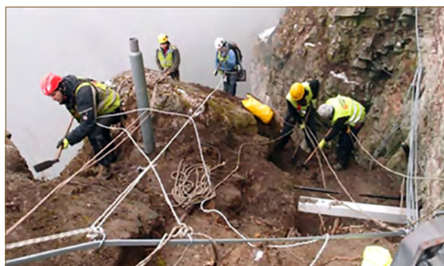
Obr. 11.54: Čistenie skalného brala v Strečne od zvetralín a vegetácie (Fekeč a kol., 2017)
