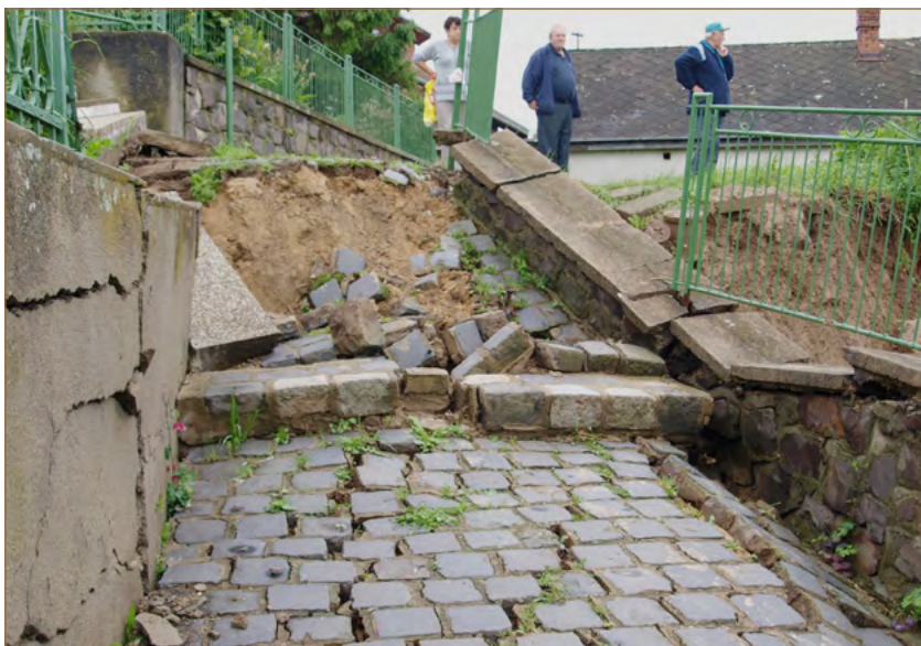
Obr. 5.17: Odlučná hrana zosuvu pod kostolom v Nižnej Myšli a poškodený múr kostola (foto: Ľ. Petro)
