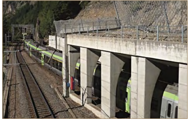
Obr. 11.74: Príklad ochrannej galérie zo Švajčiarska (zdroj: www.geobrugg.com )
