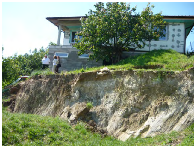
Obr. 8.9: Odľučná hrana zosuvu v obci Šenkvice (foto: V. Jánová)
