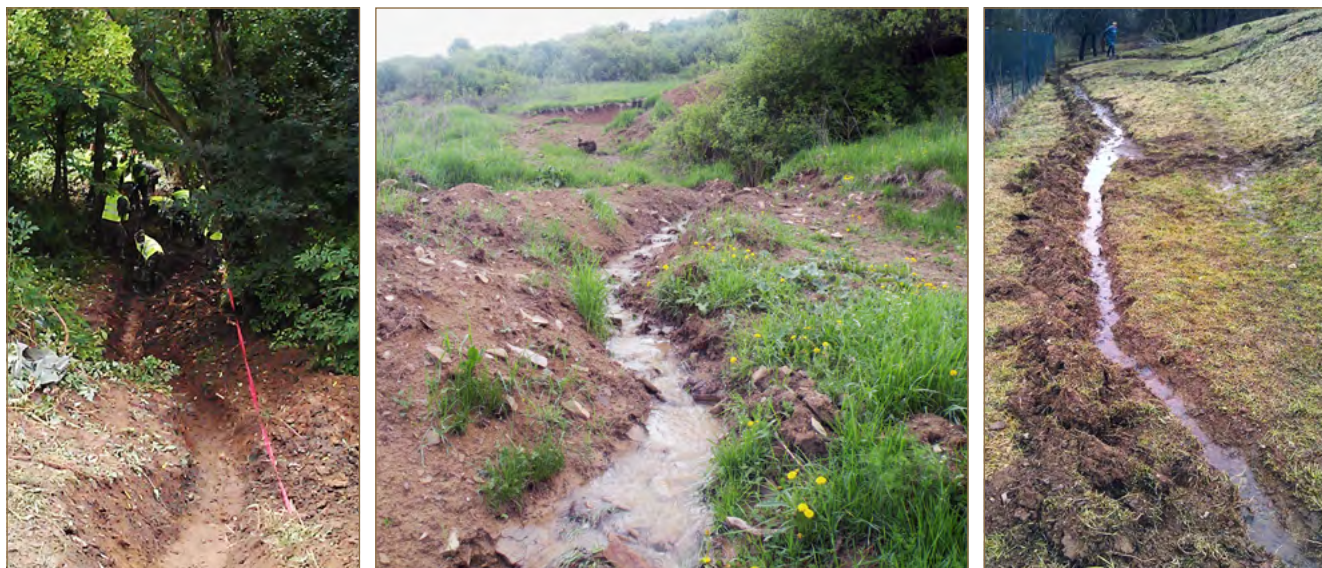
Obr. 5.25: Povrchové odvodnenie svahu je najčastejším okamžitým protihavarijným opatrením, niekedy je potrebná aj pomoc armády (foto: V. Jánová)
