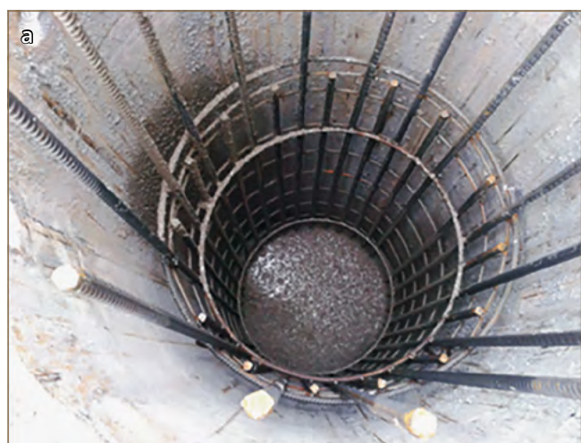
Obr. 11.41: Pohľad dovnútra pilóty pred betonážou (a) a na hlavy železobetónových pilót (b) (Gomolčák a kol., 2015)
