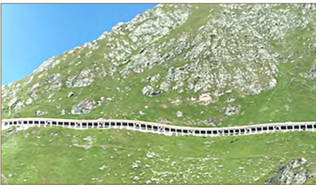
Obr. 11.75: Príklad ochrannej galérie a ochranného tunela pre turistov pod Grossglocknerom v Rakúsku (foto: V. Jánová)
