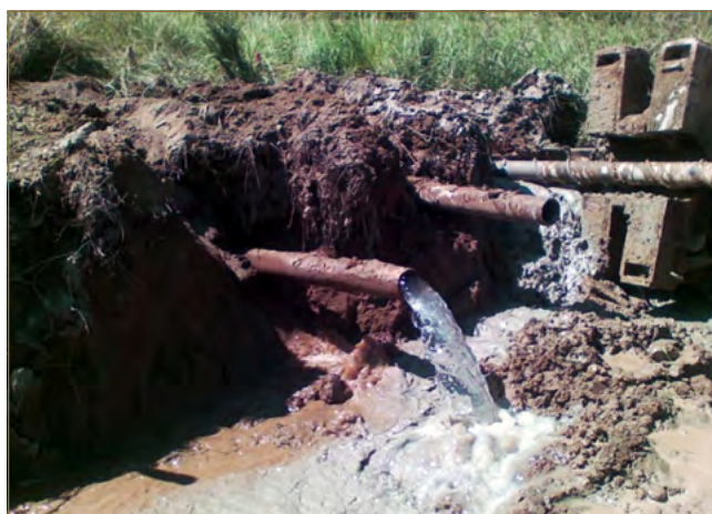
Obr. 11.17: Počiatočná výdatnosť odvodňovacieho horizontálneho vrtovej na zosuve Chmiňany (foto: M. Kopecký)
