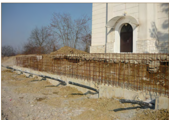
Obr. 11.31: Sanácia zosuvom poškodeného kostola v obci Nižná Myšľa pomocou kotveného oporného múra (foto: V. Jánová)
