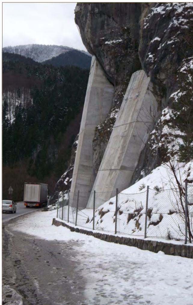
Obr. 11.67: Výstavba železobetónového oporného múra na stabilizáciu previsov nad štátnou cestou 1. triedy pod hradom Strečno (foto: V. Jánová, K. Házyová)
