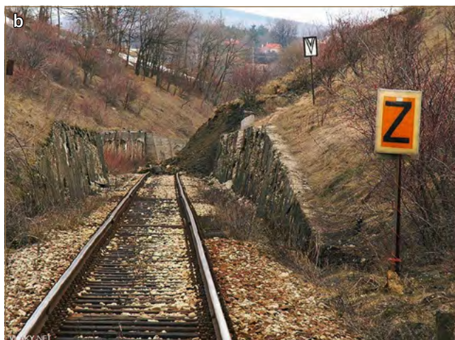
Obr. 3.21: Zosuvy vyvolané topením snehu na jar roku 2006; a – zosuv, ktorý prekryl prístupovú cestu do obce Lukavica (foto: M. Kopecký), b – zosuv, ktorý prerušil železničnú dopravu na trase Myjava Poriadie (www.vlaky.net)
