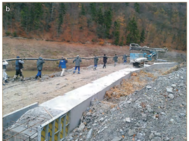
Obr. 11.43: Vrtanie horninových kotiev (a) a príprava lanovej horninovej kotvy (b) (Gomolčák a kol., 2015)
