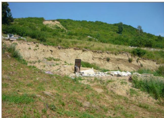
Obr. 8.35: Odlučná hrana zosuvu na cintoríne v obci Chmelnica (foto: V. Jánová)
