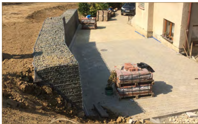
Obr. 8.14: Gabiónový múr vybudovaný v rámci sanačných prác v obci Petrovanoch (foto: V. Jánová)
