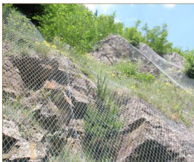
Obr. 11.66: Ukážka závojského systému z ocelových sietí (zdroj: www.geobrugg.com )
