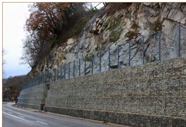
Obr. 11.69: Múr z drôto-kamenných košov zabezpečujúci skalný odkryv na Devínskej ceste (foto: B. Prelovský)
