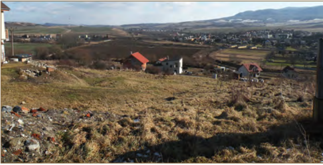
Obr. 8.28: Pohľad na sanovaný svah zosuvu v Kapušanoch, kde bola pôvodne plánovaná individuálna bytová výstavba (foto: V. Jánová)
