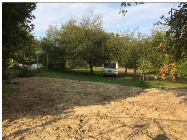
Obr. 11.12: Svah po utesnení trhlín na zosuve v Kapušanoch (foto: V. Jánová)
