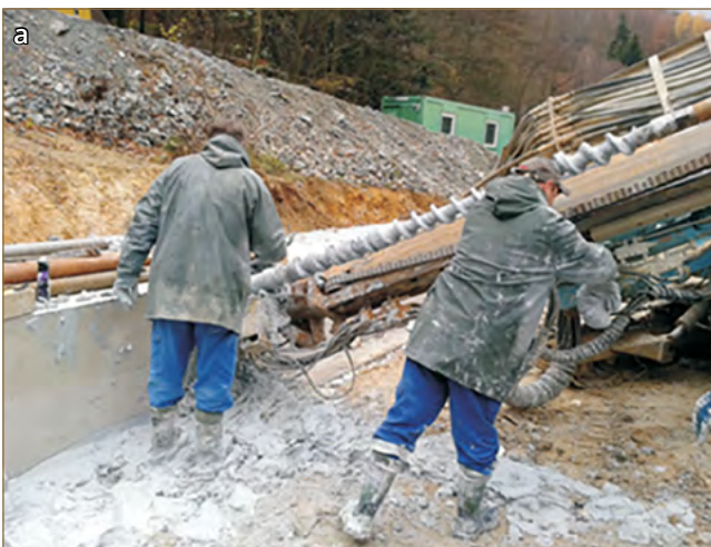
Obr. 11.43: Vrtanie horninových kotiev (a) a príprava lanovej horninovej kotvy (b) (Gomolčák a kol., 2015)
