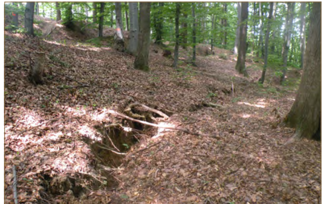
Obr. 8.41: Otvorené trhliny v telese zosuvu v Prešove na Horárskej ulici (foto: V. Jánová)
