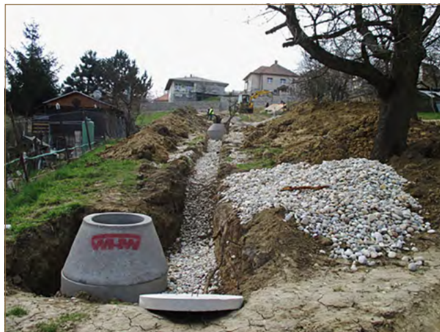
Obr. 8.11: Výstavba drenážno-stabilizačného rebra na zosuve v Šenkviach (Fekeč a kol., 2015)
