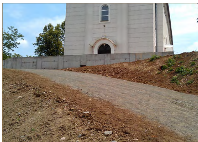
Obr. 11.31: Sanácia zosuvom poškodeného kostola v obci Nižná Myšľa pomocou kotveného oporného múra (foto: V. Jánová)
