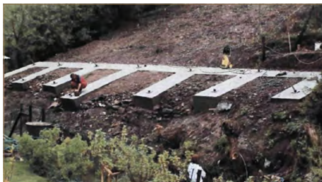
Obr. 8.16: Kotvený železobetónový rošt zabezpečujúci čelo zosuvu v Čadci (foto: M. Novotný)
