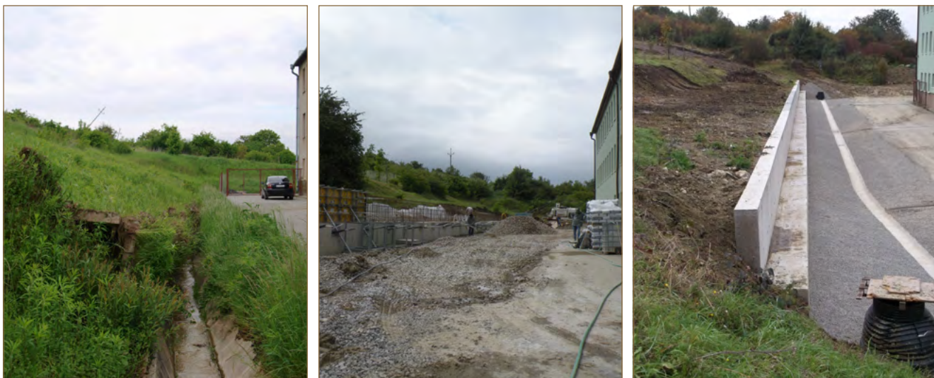
Obr. 8.61: Čelo zosuvu za základnou školou, v strede budovanie kotvenej pilótovej steny, vpravo jej výsledný vzhľad (foto: L. Petro, V. Jánová, K. Házyová)
