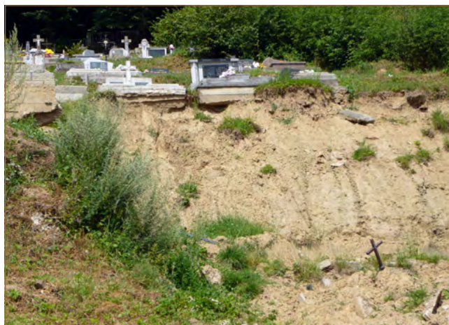
Obr. 8.36: Detail odlučnej hrany zosuvu v Chmelnici (foto: V. Jánová)
