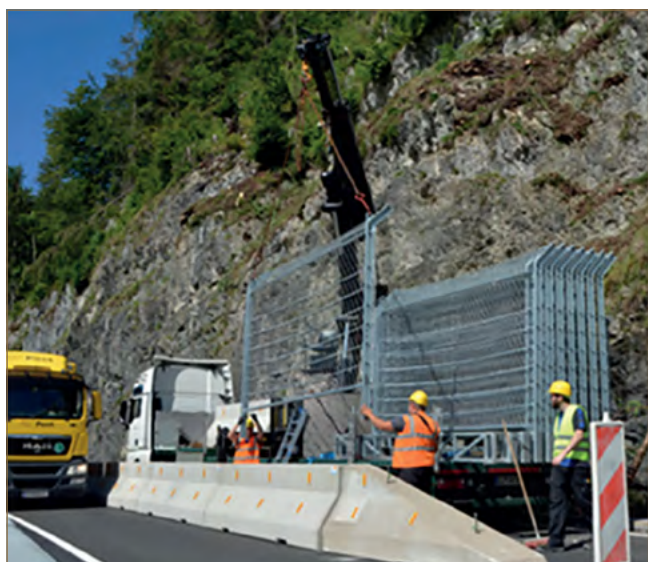
Obr. 11.61: Príklad mobilných plotových bariér Geobrugg (zdroj: www.geobrugg.com )
