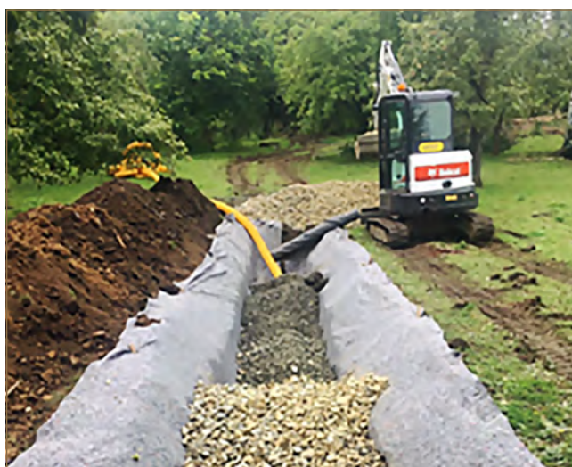
Obr. 8.27: Budovanie drenážno-stabilizačného rebra v roku 2019 na zosuve Kapušany (foto: P. Tupý)
