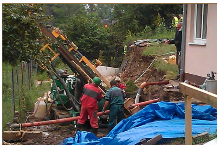
Obr. 5.20: Odlučná hrana zosuvu vo Vinohradoch nad Váhom (vľavo) a budovanie mikropilótovej steny na záchranu rodinného domu (vpravo) (foto: V. Jánová)
