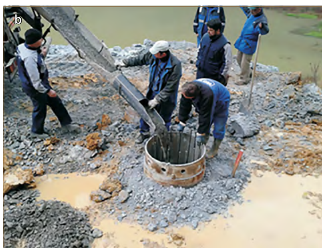
Obr. 11.40: Vŕtanie pilóty – vrt je chránený výpažnicou (a) a betonáž pilóty (b) v lokalite Hodruša-Hámre (Gomolčák a kol., 2015)
