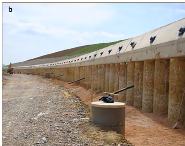
Obr. 11.39: Sanácia zárezu v zosuve na trase R4 Košice – Milhošť pilótvou stenou: a) aktivizácia zosuvu pred dokončením pilótovej steny, b) dokončená pilótvá stena (foto: M. Kopecký)
