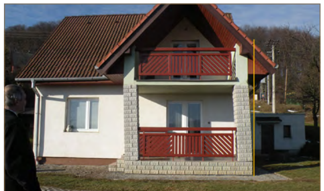
Obr. 8.42: Dom v zosuvnom území Pod Wilec hôrkou s porušenou statikou, ktorý musel byť asanovaný (foto: V. Jánová)
