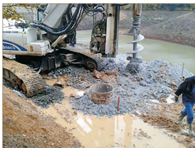
Obr. 11.40: Vŕtanie pilóty – vrt je chránený výpažnicou (a) a betonáž pilóty (b) v lokalite Hodruša-Hámre (Gomolčák a kol., 2015)
