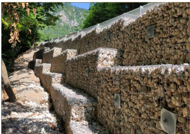
Obr. 11.29: Kotvený gabiónový múr na Muráni (foto: B. Prelovský)
