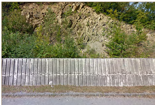
Obr. 11.72: Príklady záchytných múrov na odkryvoch severne od obce Demjata a na ceste medzi Liptovskými Matiašovcami a Hutami (zdroj: www.google.sk/maps )
