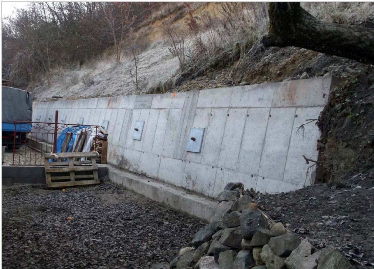
Obr. 100: Košice – ul. Slivník – zrealizované sanačné opatrenia – kotvený oporný železobetónový múr (2014)
