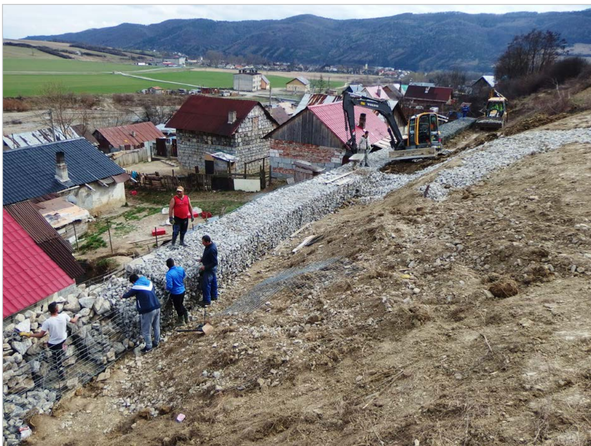
Obr. 83: Pečovská Nová Ves – pohľad na gabiónový múr so stabilizačným prísypom a drenážno-stabilizačným rebrom (2016)
