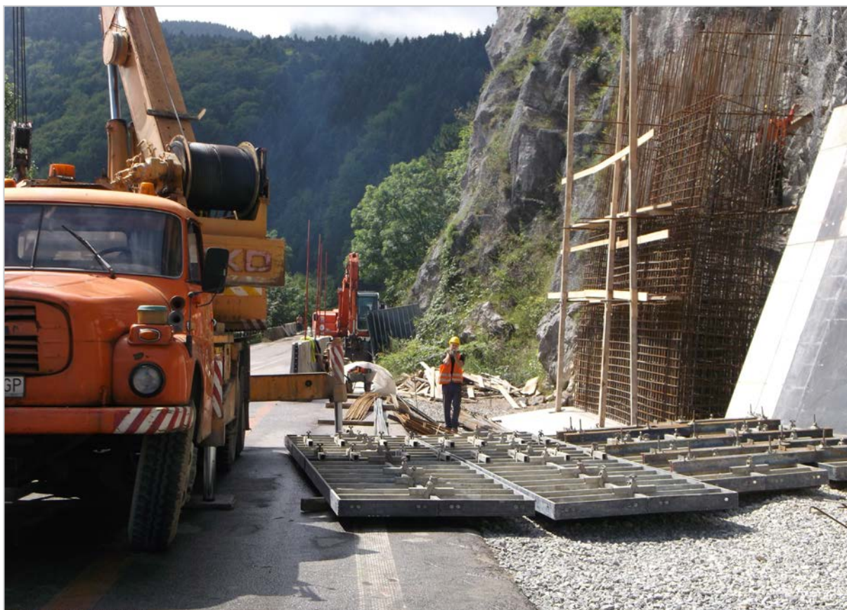
Obr. 72: Strečno – budovanie oporného múru (foto: archív MŽP SR, 2017)
