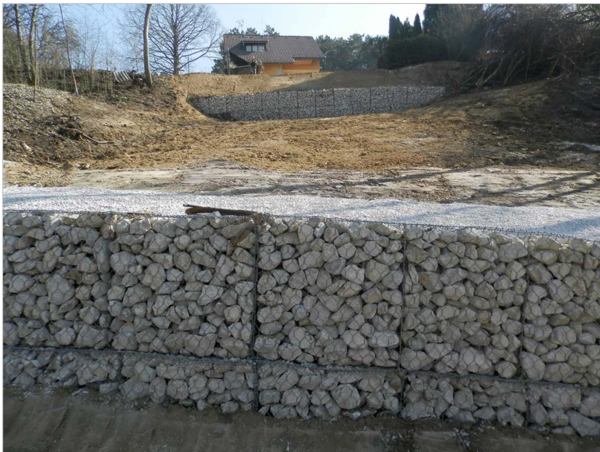
Obr. 57: Obec Banka pri Piešťanoch – pohľad na oblasť zosuvu po ukončení sanácie (2014)
