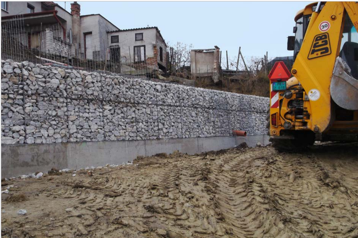
Obr. 50: Šenkvice – čelný pohľad na druhý kotvený gabiónový múr počas výstavby (2014)
