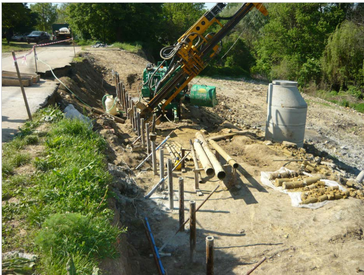
Obr. 54: Vinohrady nad Váhom – zabezpečenie komunikácie mikropilótami (2012)
