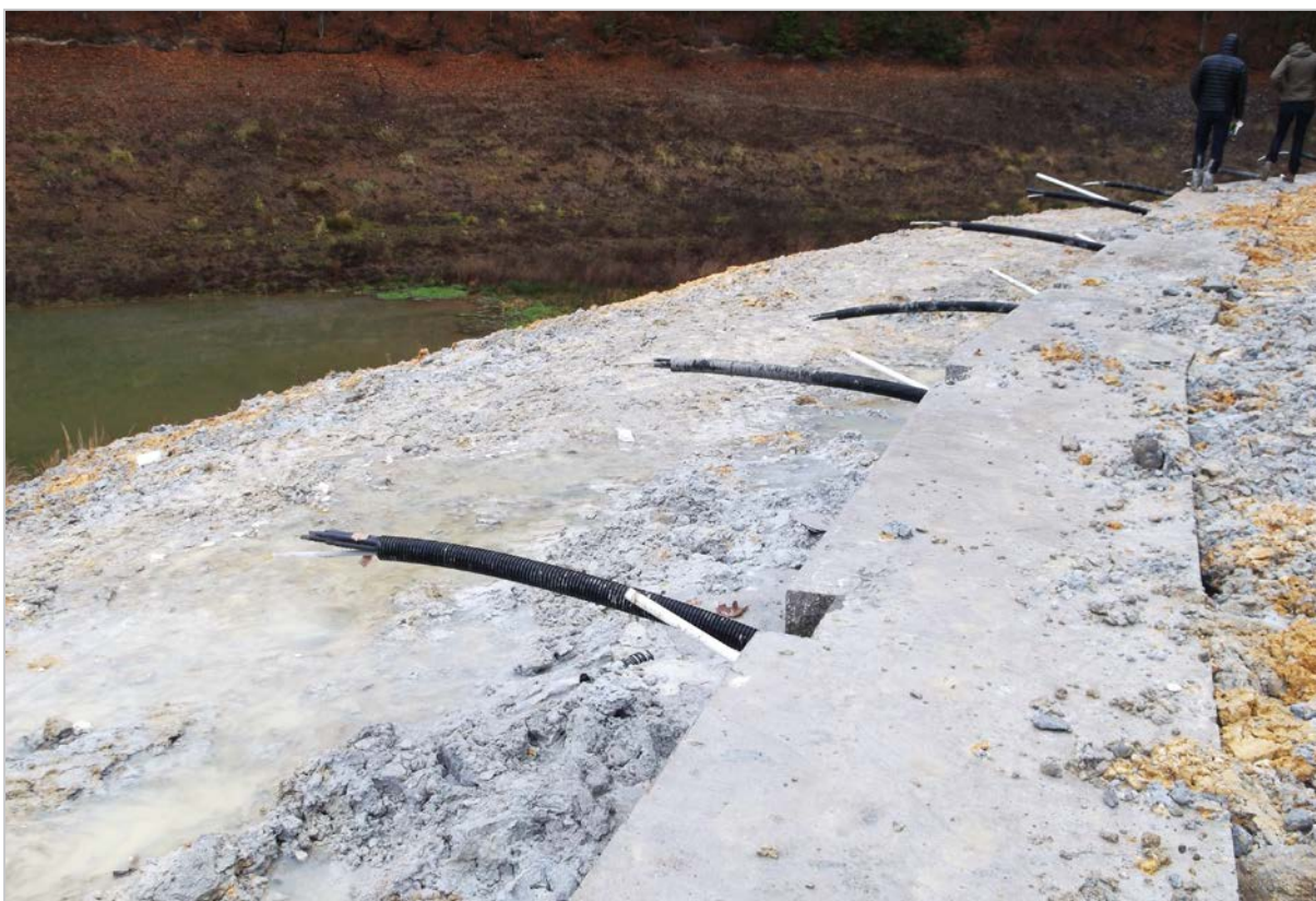
Obr. 65: Hodruša-Hámre – kotvená pilótová stena pred napnutím kotiev (2015)
