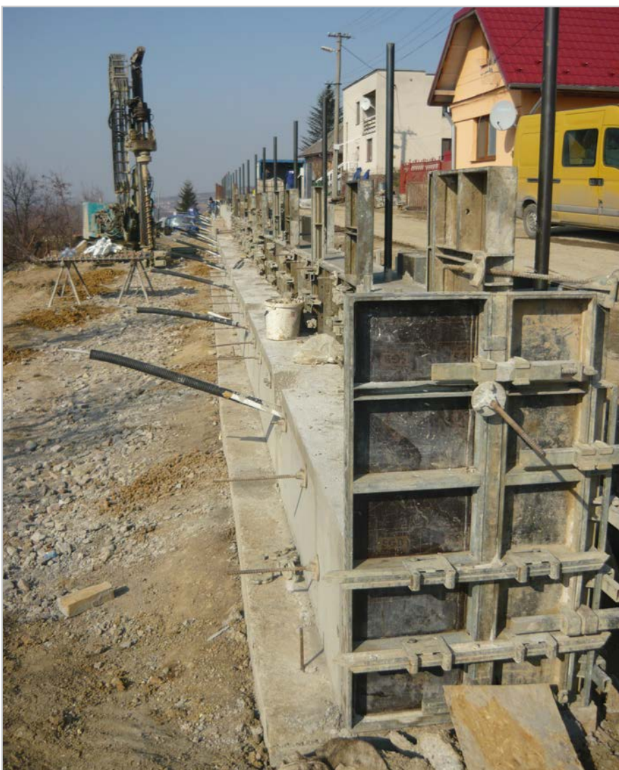
Obr. 92: Nižná Myšľa – výstavba kotveného oporného múru (2012)
