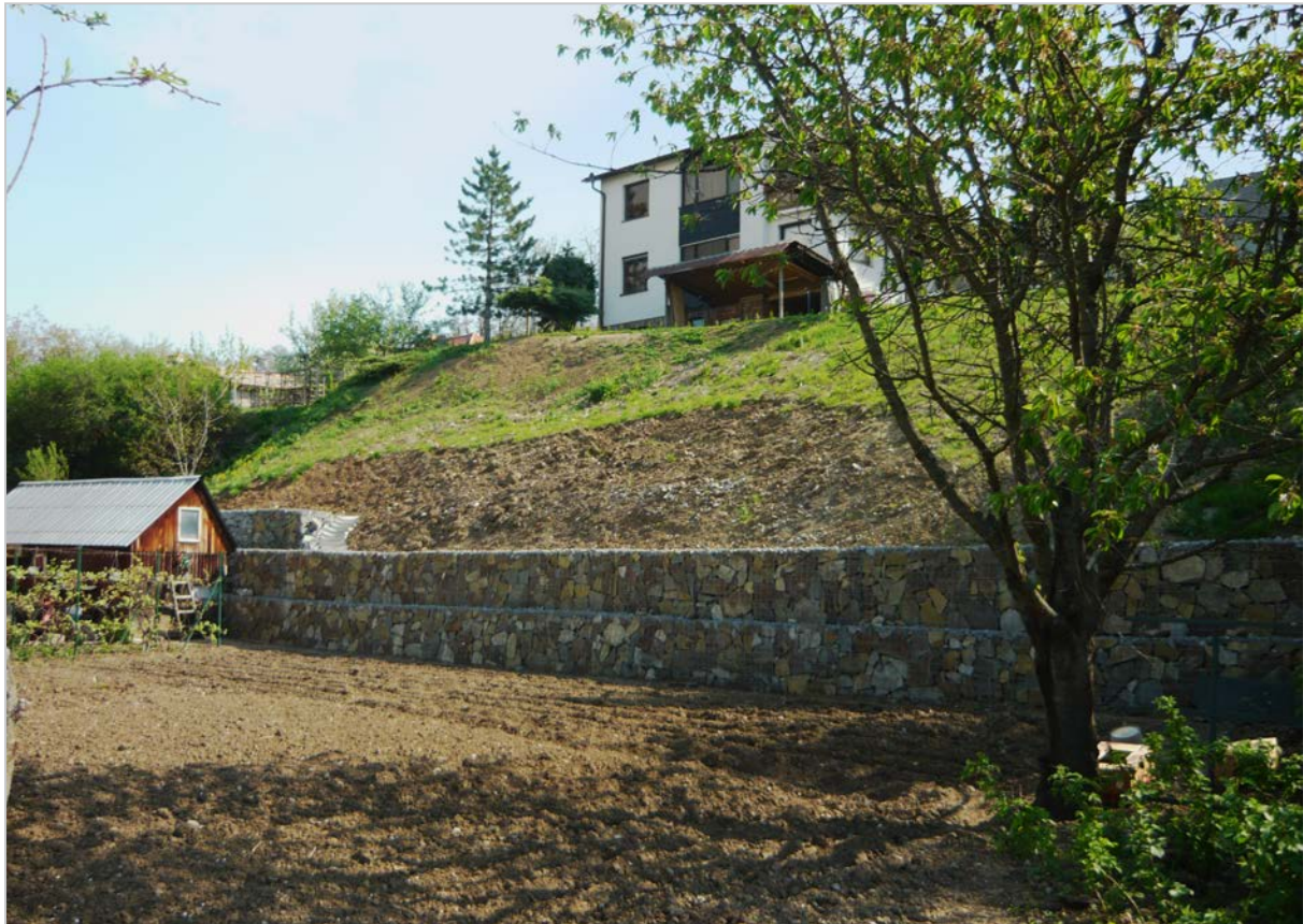
Obr. 33: Čelo zosuvu v Krupine pred sanáciou (hore) a po ukončení sanácie (dole)
