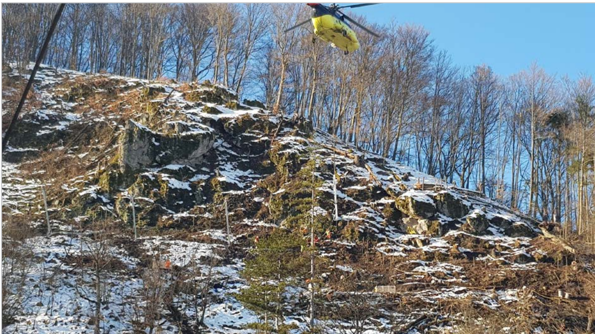
Obr. 62: Kozelník – doprava materiálu vrtuľníkom počas sanačných prác (12/2017)
