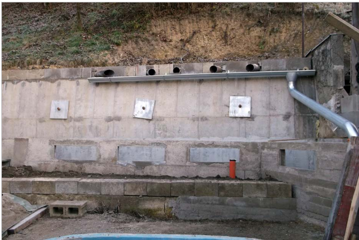
Obr. 101: Košice – Krásna – Ulica 1. mája – kotvený oporný múr s vyústením subhorizontálnych vrtov (2014)
