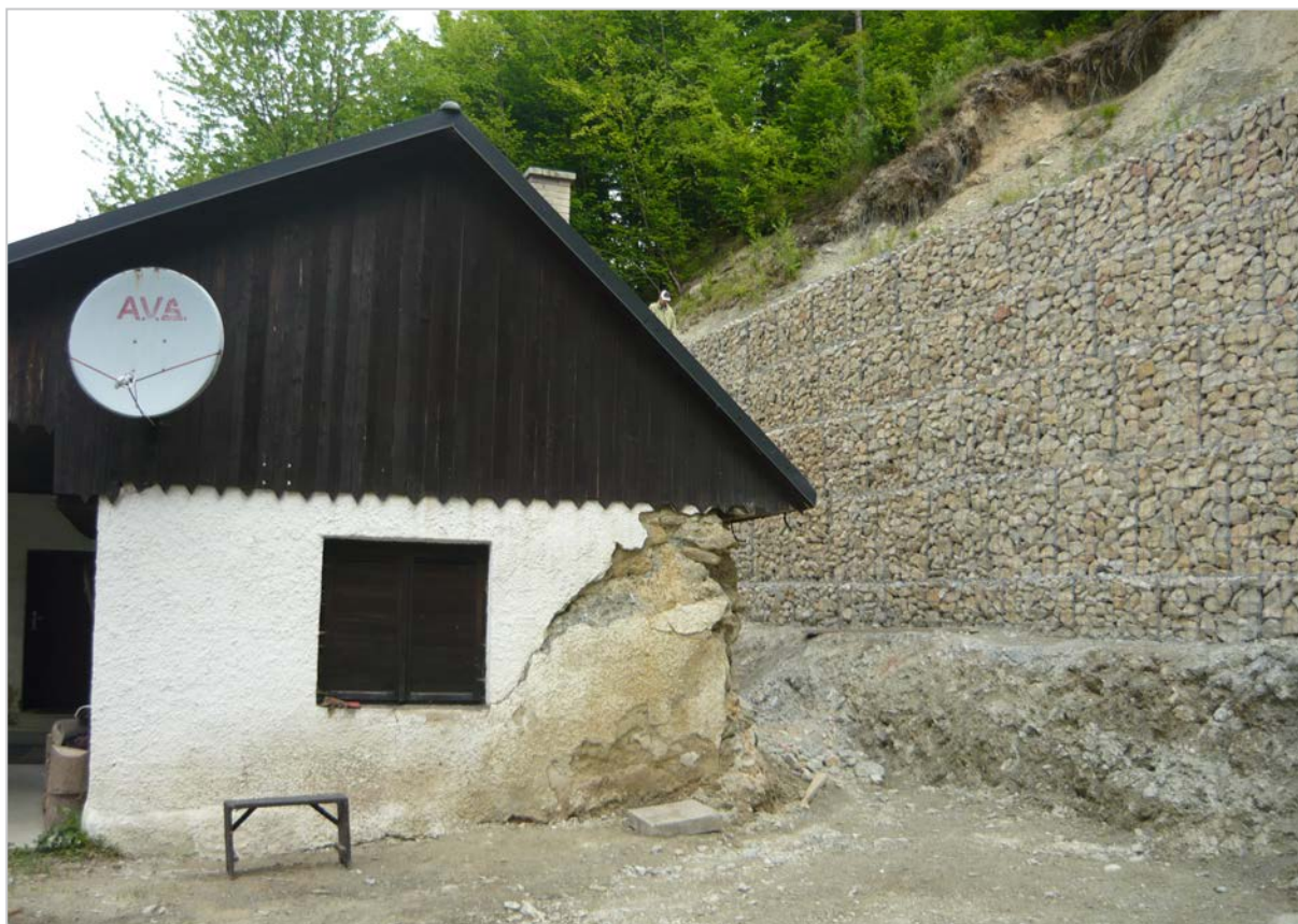
Obr. 97: Kojšov – realizované sanačné opatrenia v obci – oporný kotvený gabiónový múr (2012)
