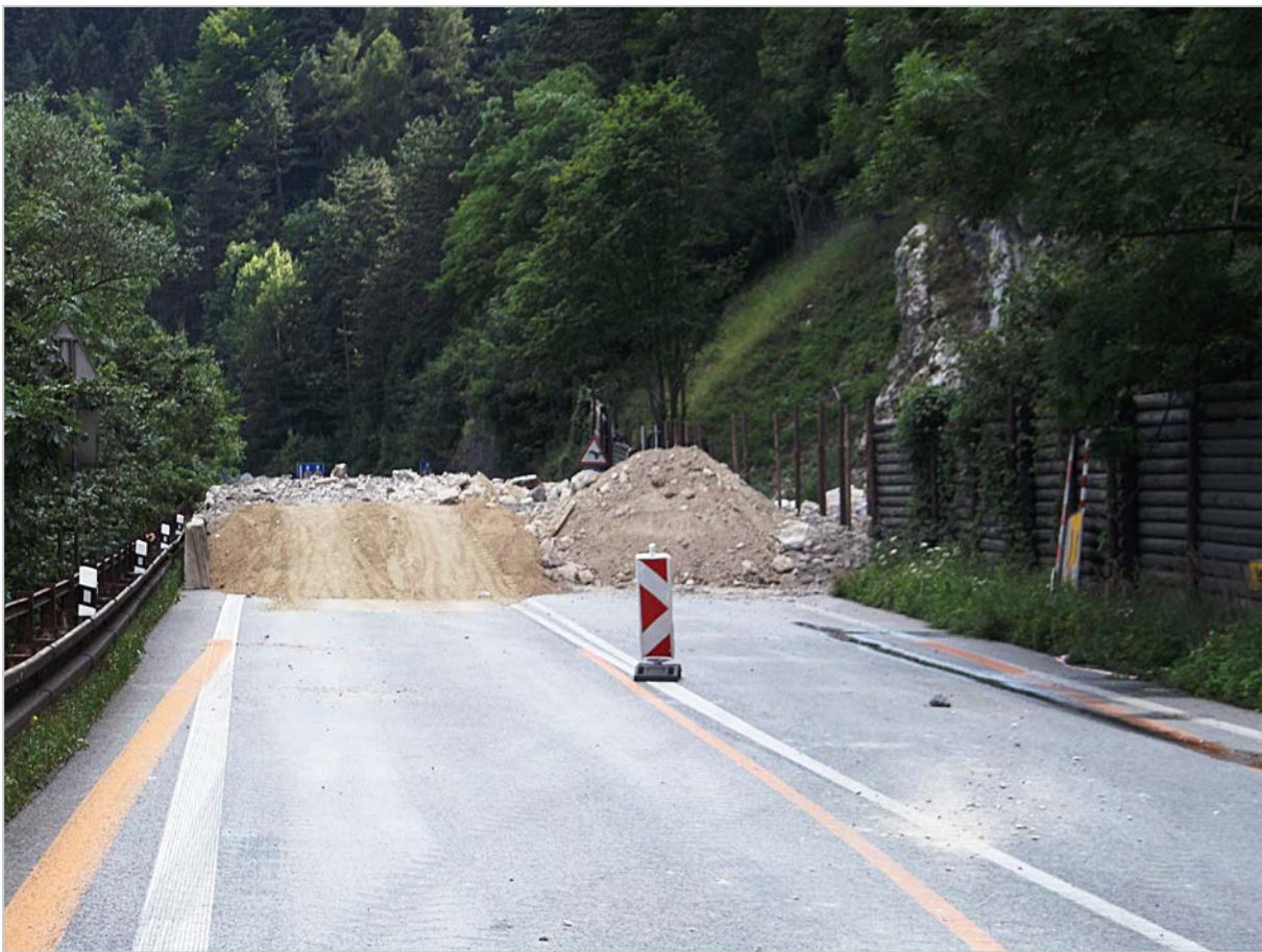
Obr. 74: Strečno – príprava ochranného „vankúša“ na ceste pred riadeným odstránením skalného bloku (2017)
