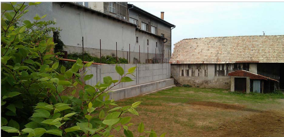
Obr. 91: Nižná Myšľa – zrealizovaný oporný múr po ukončení sanácie (2012)
