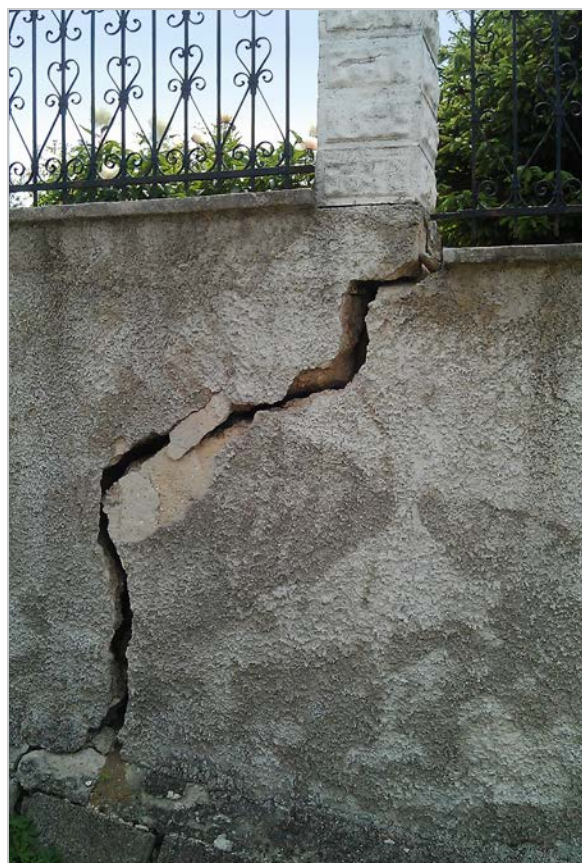
Obr. 21: Porušený oporný múr v Nižnej Myšli
