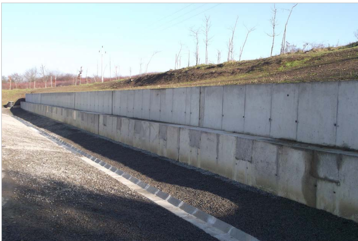
Obr. 95: Nižná Myšľa – konečný vzhľad kotvenej pilótovej steny (2014)
