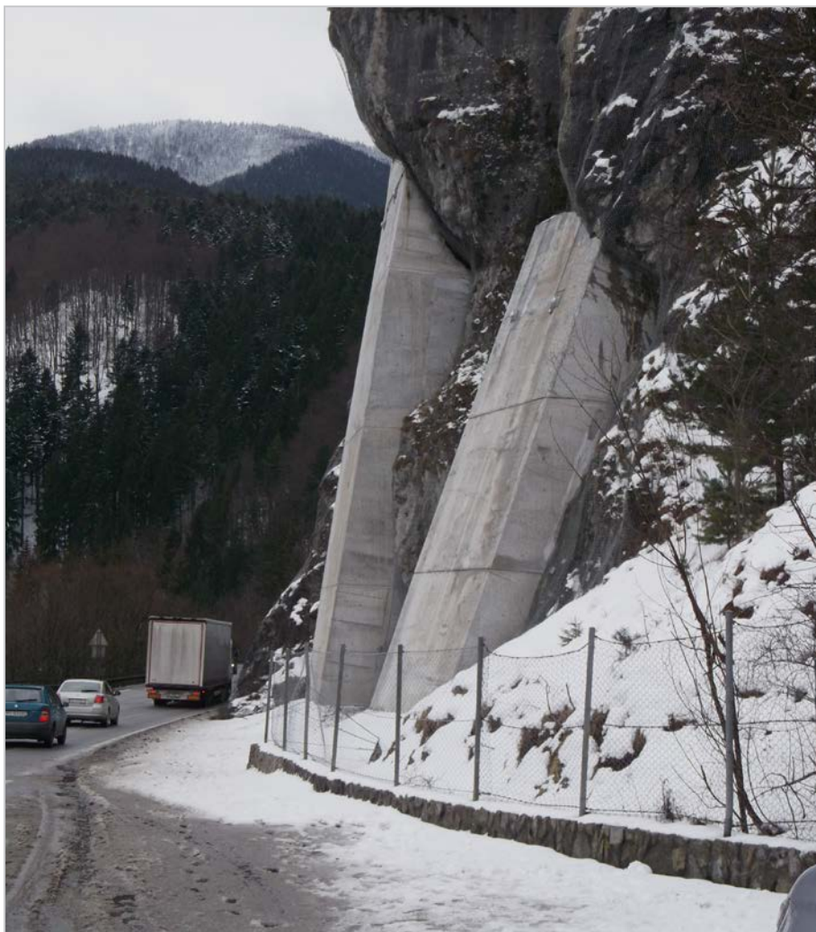
Obr. 73: Strečno – hotové oporné múry (foto: archív MŽP SR, 01/2018)
