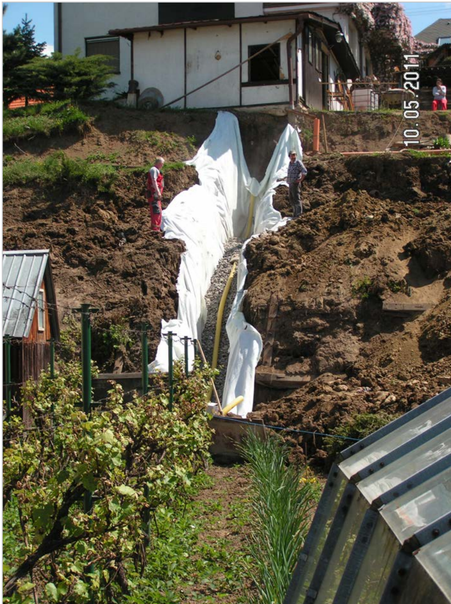
Obr. 67: Krupina – drenážno-stabilizačné rebro počas výstavby (2011)
