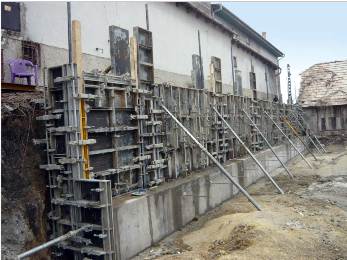
Obr. 90: Nižná Myšľa – výstavba oporného múru (2012)
