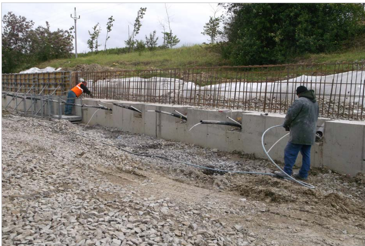
Obr. 94: Nižná Myšľa – výstavba kotvenej pilótovej steny nad školou (2014)
