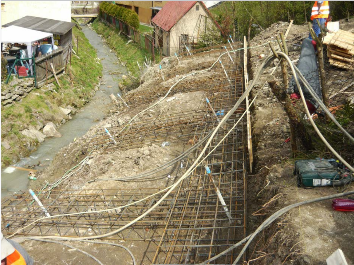
Obr. 69: Čadca – realizácia stabilizačnej konštrukcie v čele zosuvu (04/2012)
