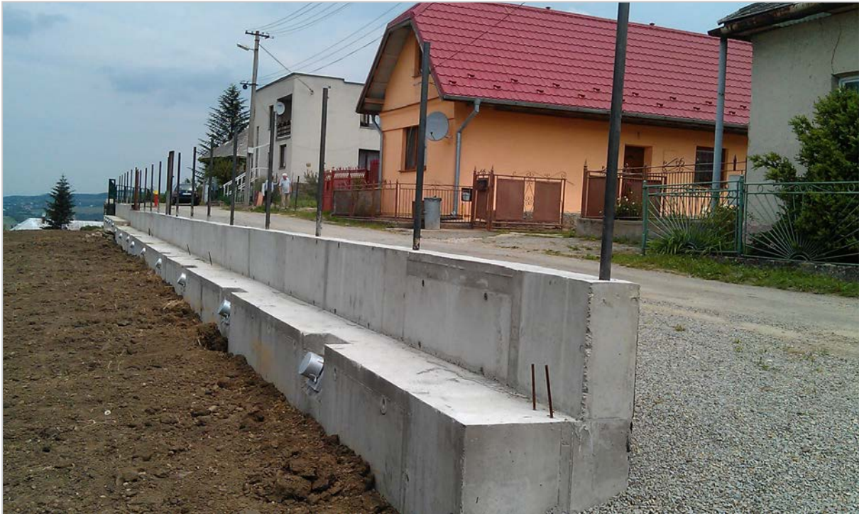
Obr. 93: Nižná Myšľa – kotvený oporný múr po ukončení výstavby v roku 2012
