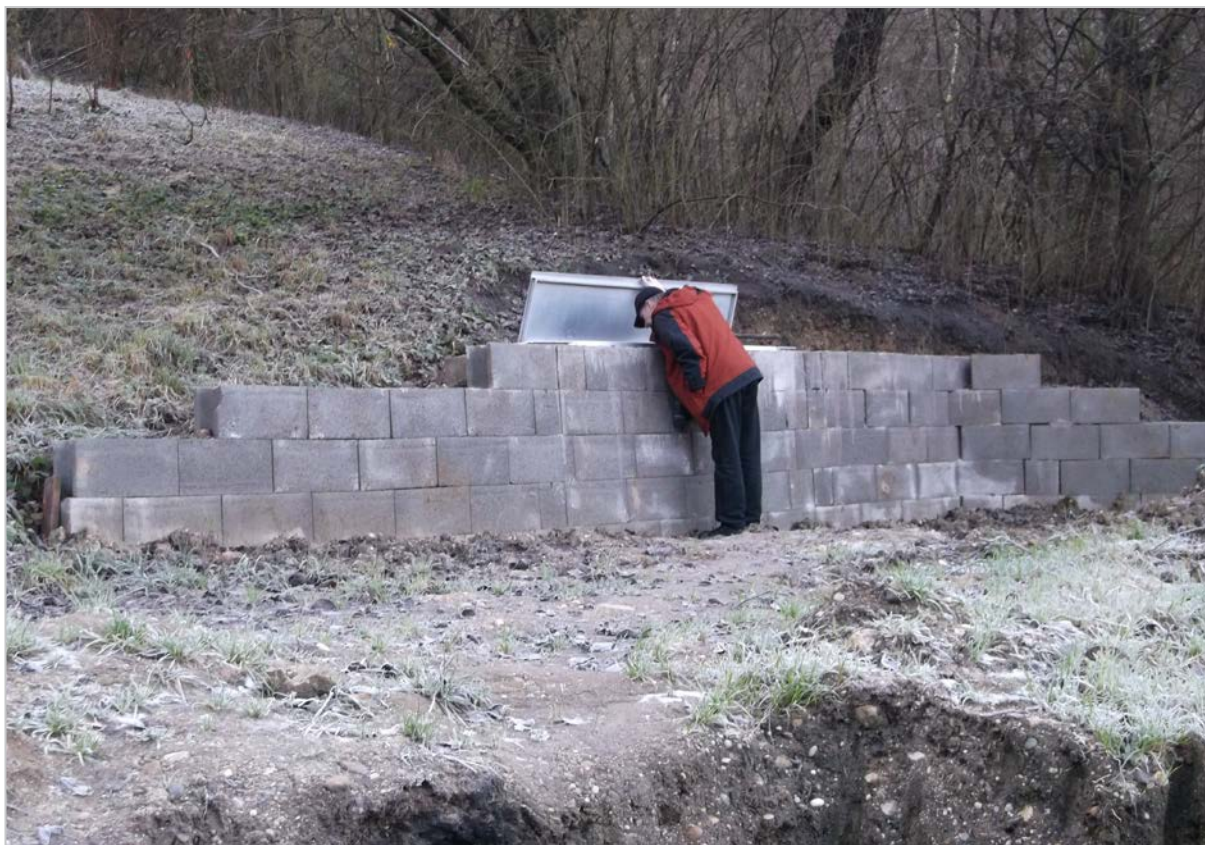
Obr. 98: Košice – Prvosienková ul. – zrealizované subhorizontálne odvodňovacie vrty (2014)
