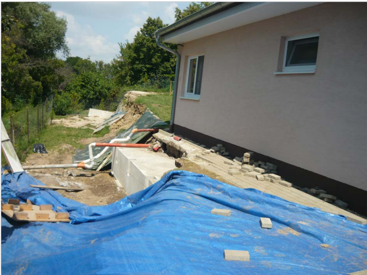
Obr. 53: Vinohrady nad Váhom – podchytené základy rodinného domu (2011)
