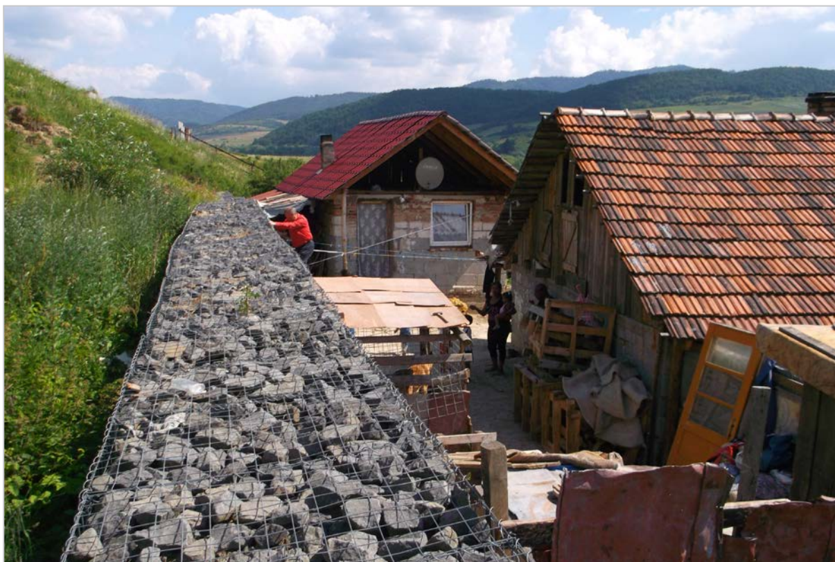
Obr. 82: Pečovská Nová Ves – ukladanie drôtených košov pri budovaní gabiónového múra (2016)
