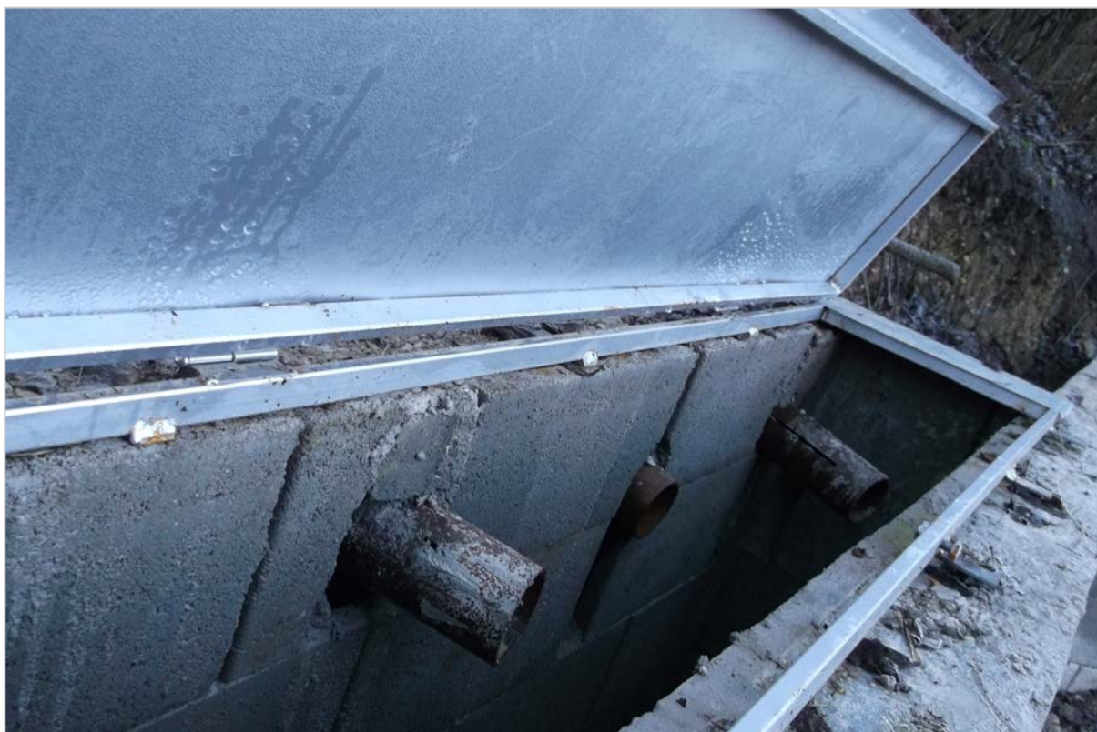
Obr. 99: Košice – Prvosienková ul. – vyústenie subhorizontálnych vrtov (detail, 2014)
