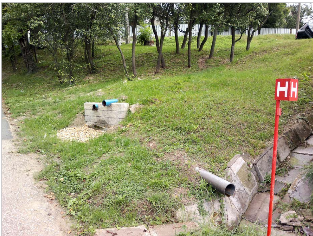
Obr. 103: Nižná Hutka – vyústenie subhorizontálnych vrtov (2014)
