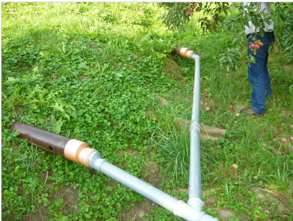
Obr. 51: Šenkvice – odvedenie vôd zo subhorizontálnych vrtov (2011)
