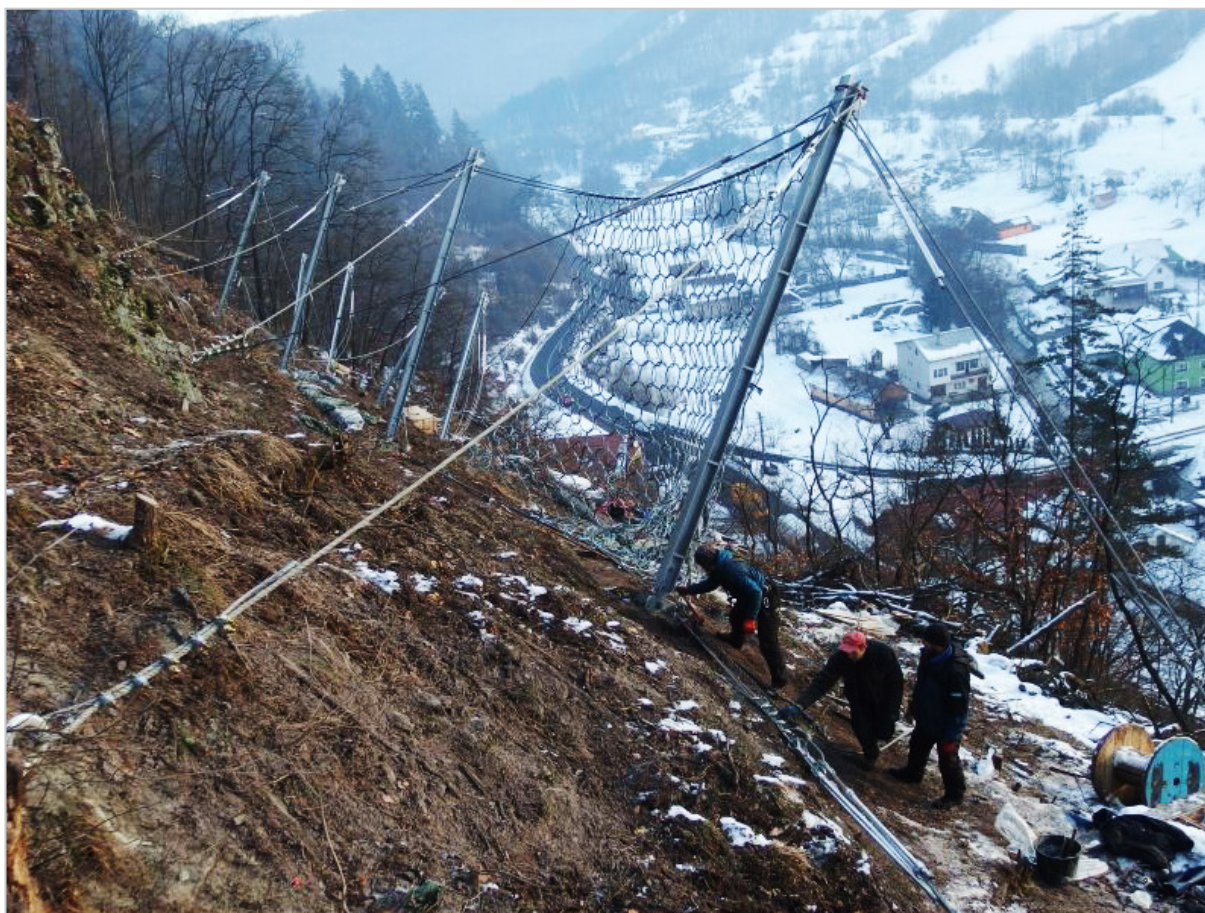
Obr. 63: Kozelník – inštalácia záchytnej dynamickej bariéry (12/2017)
