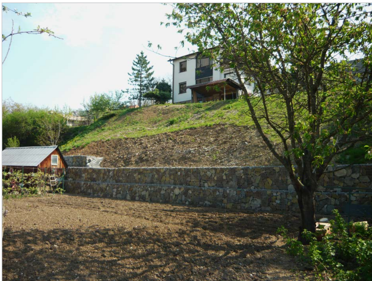
Obr. 68: Krupina – pohľad na upravený terén po ukončení sanácie (05/2012)
