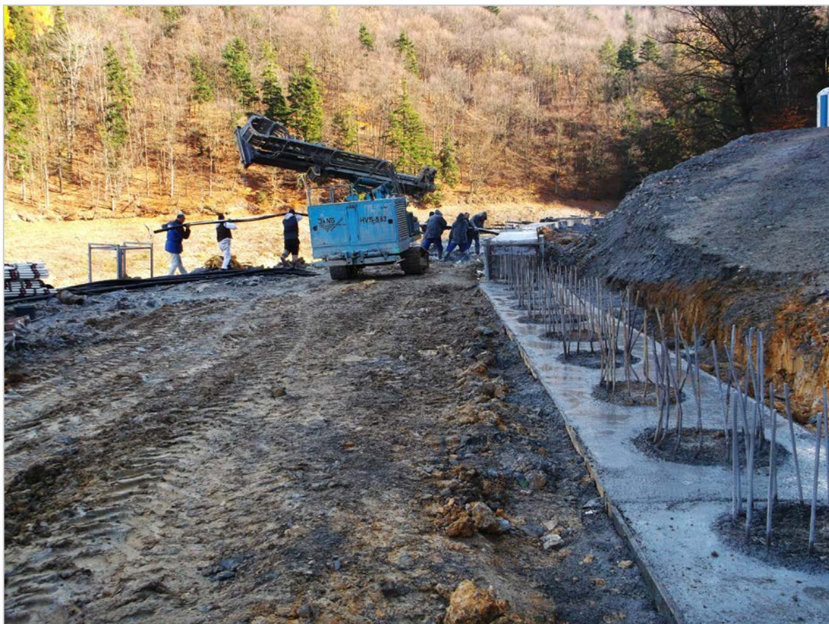
Obr. 64: Hodruša-Hámre – kotvená pilótová stena počas výstavby (2015)
