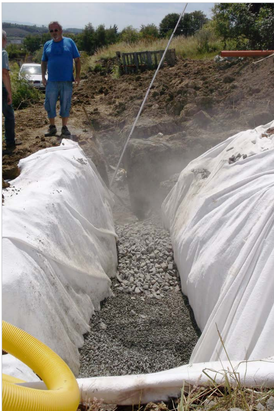
Obr. 80: Kapušany – realizácia drenážno-stabilizačného rebra (2014)
