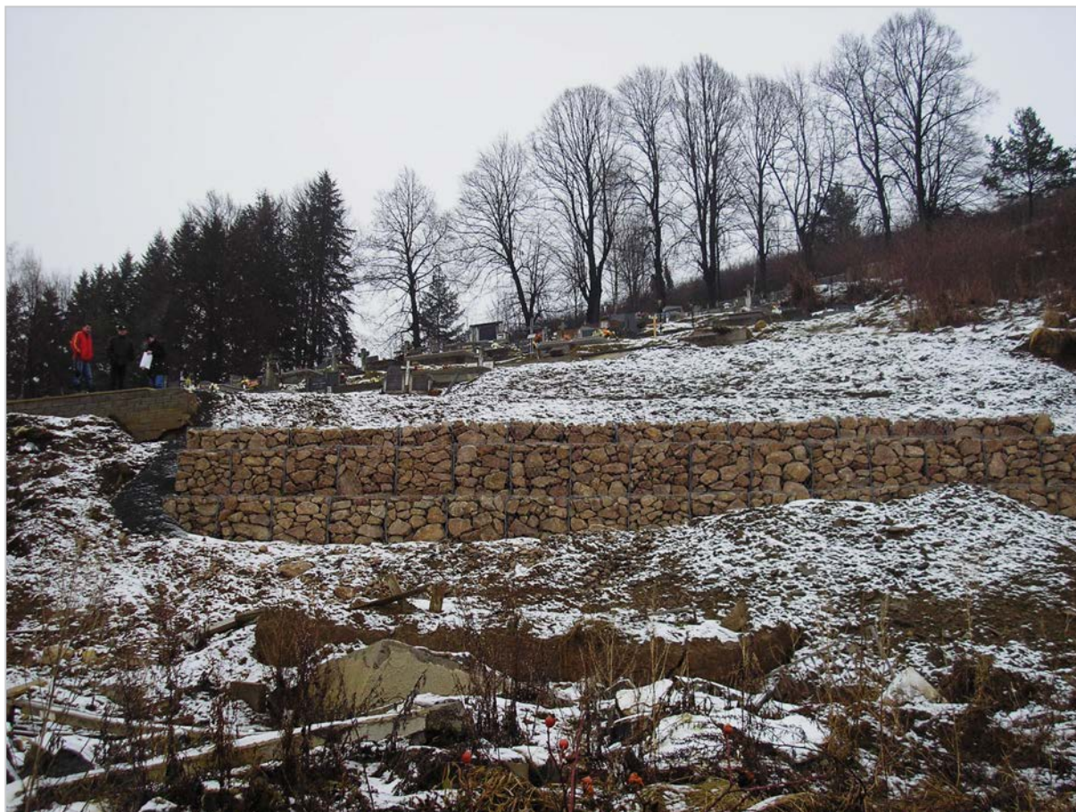
Obr. 76: Chmeľnica – vybudovaný gabiónový múr (2012)
