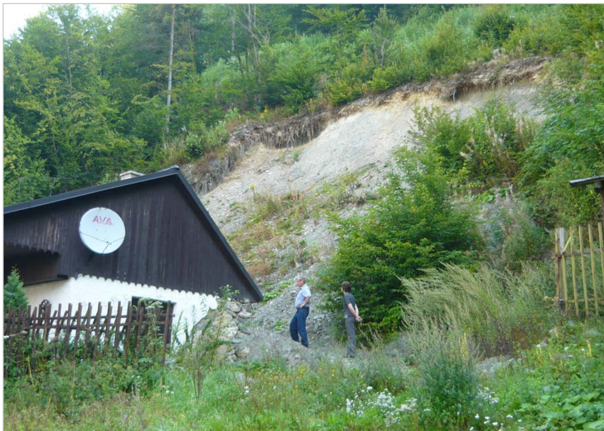
Obr. 96: Kojšov – zosuvom poškodený rodinný dom v obci (2011)
